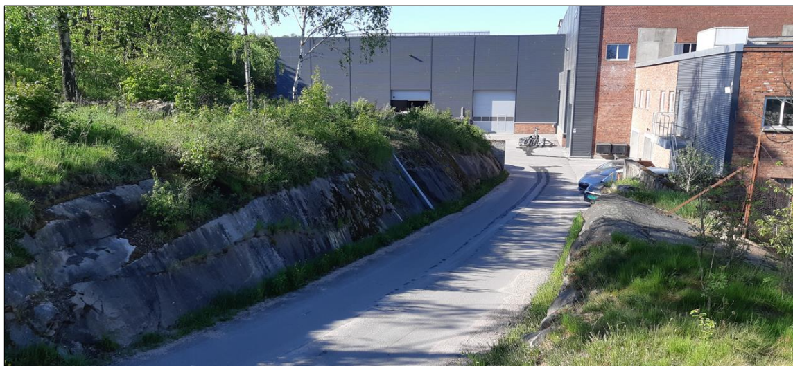
Figur 4.6: Står i nord og tar bilde mot Østfold Marineservice i syd (Befaring 16.05.2024).
