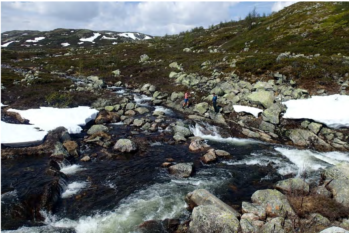
Bilde 18, frå inntak med innmåling av damende
