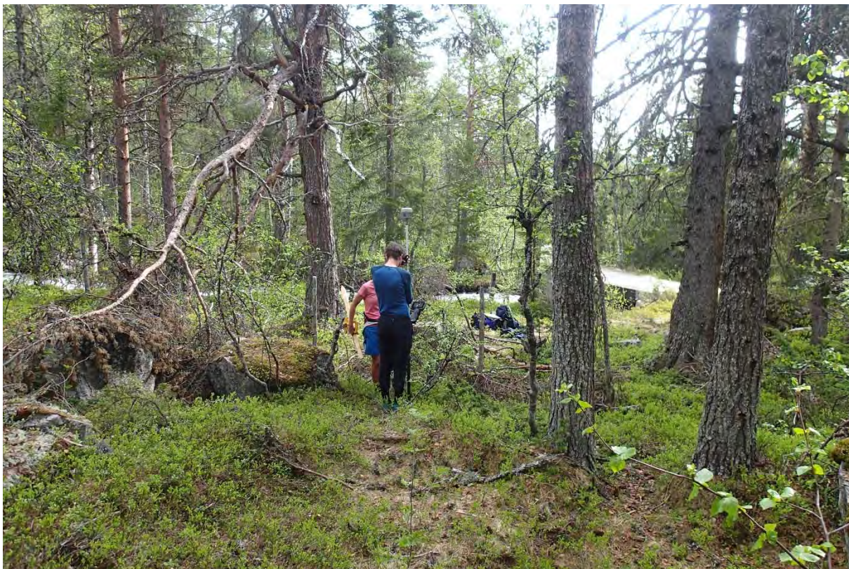
Bilde 1, utstikking av innløp kraftstasjon
