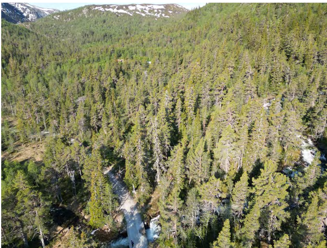
Bilde 4, oversikt mot kraftstasjonen fra aust. Mast for tilkopling visar til venstre for vegen
