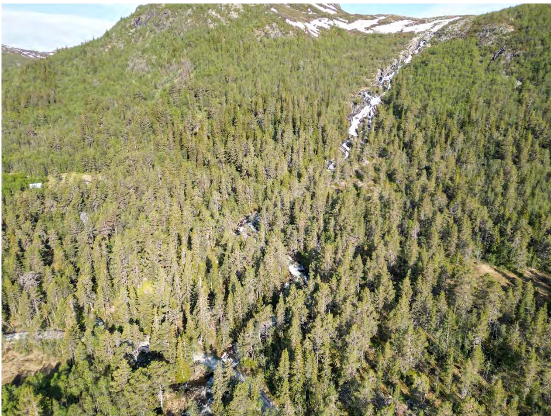
Bilde 6, oversikt over nedre del av anlegget frå sør-aust
