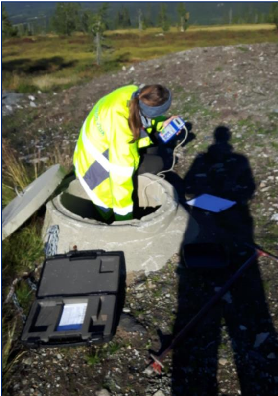
Figur 6. GB02 ved Klevmoseterhøgda vannverk.
