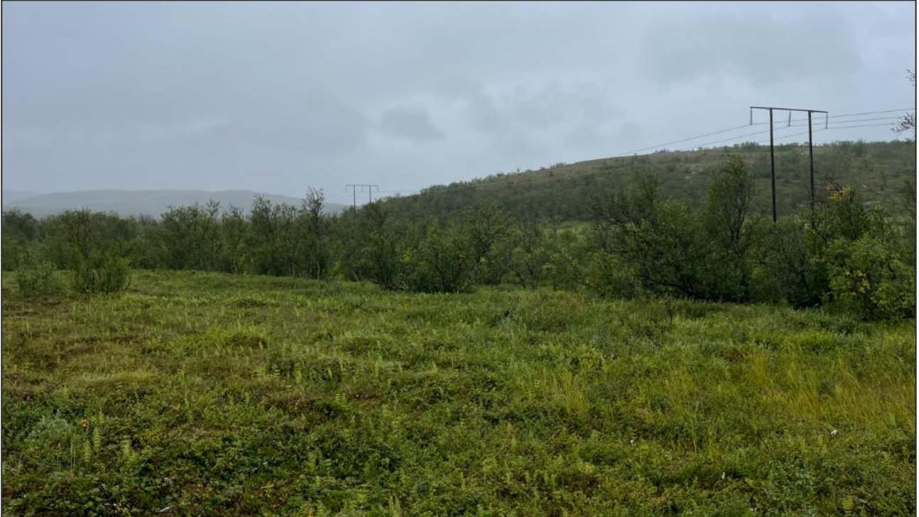
Figur 2-57. Før elvekryssing mellom mast 364 og 365.
