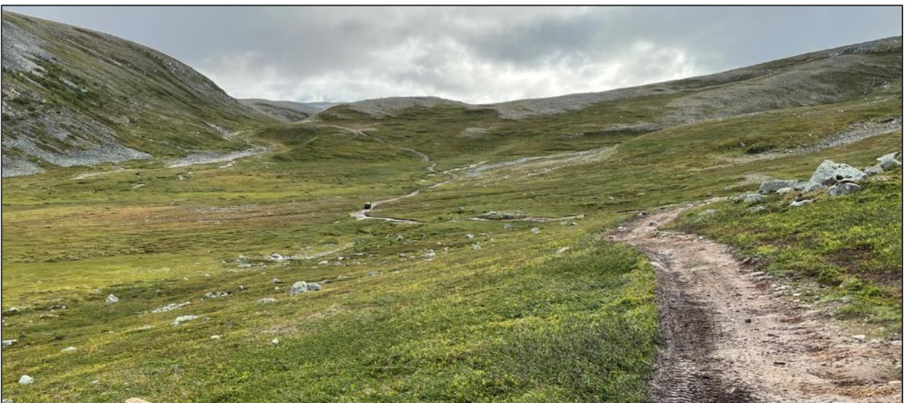
Figur 2-42. Eksisterende kjørespor i øvre del av traseen.
