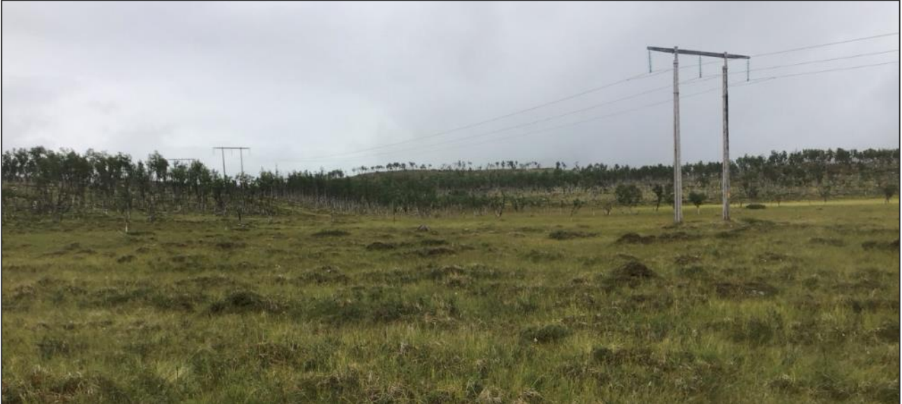
Figur 2-13. Adkomst til mast 65 på myr sett mot mast 64.
