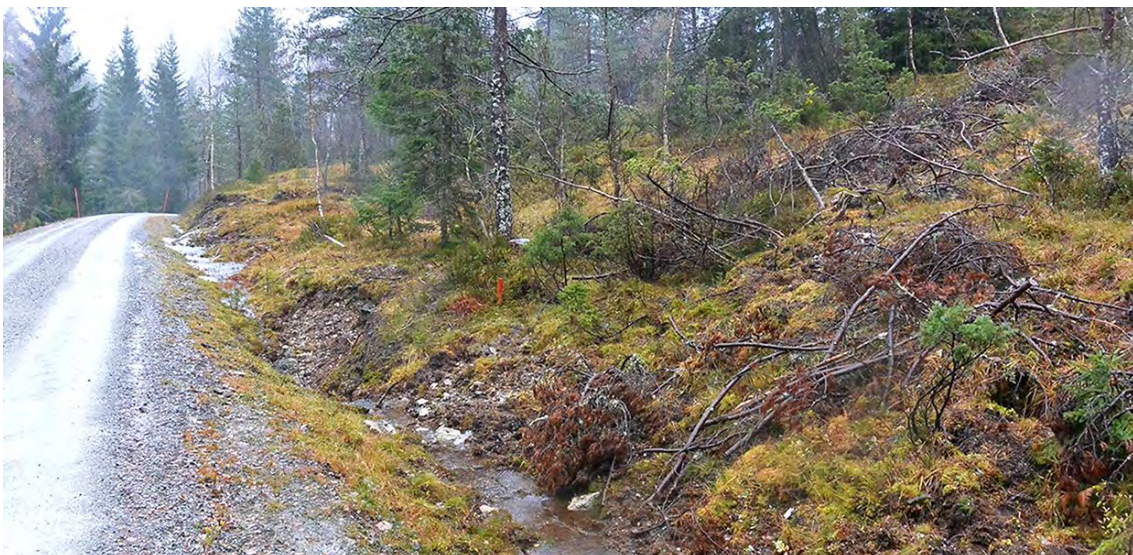
Figur 3-25 er tatt frå Steinsvegen overfor det avsette området, som vil ligge til høgre i biletet. Området er relativt flatt og eigna for riggområde, både med omsyn til plassering med nærleik til dam og inntakskonstruksjon og i høve terrengtilpassing der inngrep som følge av opparbeiding vil være mindre og relativt enkle å sette i stand.
