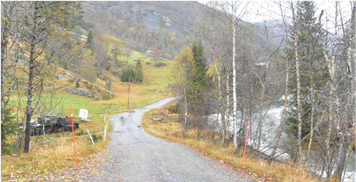
Figur 3-24 Biletet, teke like ca. 100 m over dam og inntakskonstruksjon, syner at det er liten høgdskilnad mellom vegen sitt lågbrekk og elva.
