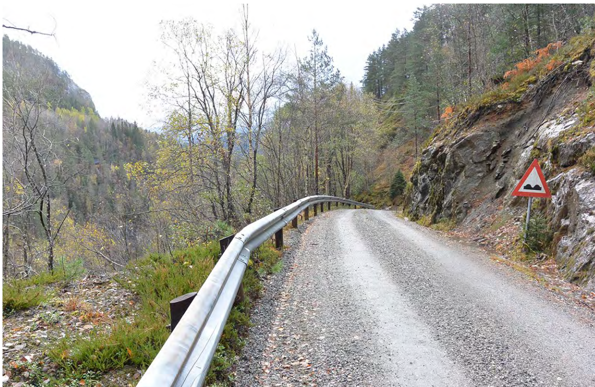
Bilete 2-2 syner vegen som ligg på ei hylle i det sidebratte terrenget, her like før vegen slynger seg ned mot hovuddalføret. 22kV linja har mastepunkt på knausen til høgre for vegen i biletet.
