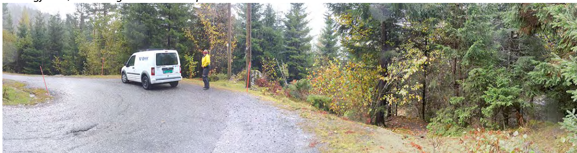
Figur 3-22 Ved øvre kryssing er det rom for å legge inn ein større horisontalradius på utsida av stolpen. Ein lyt utvise varsemd ved arbeid ved lina og straum lyt kopløst frå når det vert utført arbeid tett på og under lina, som kan være risikofyllt.
