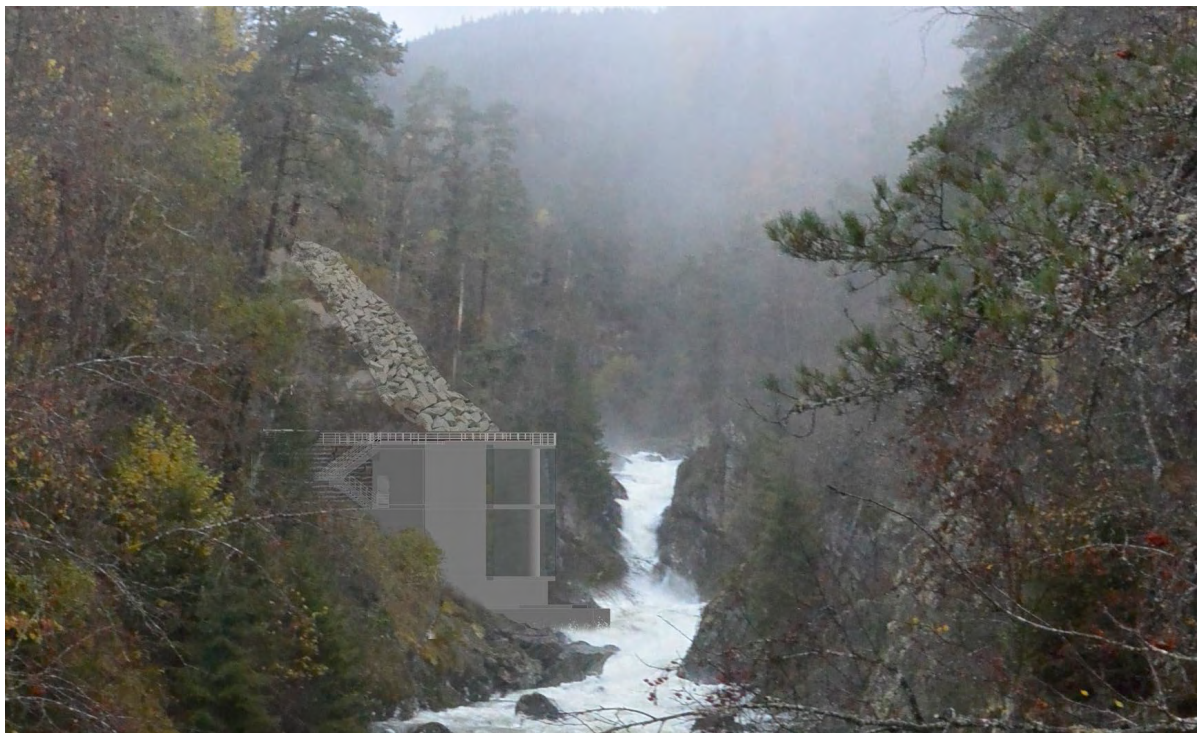
Bilete 3-3 syner eit utsnitt frå illustrasjon frå brua. Kraftstasjonen har ei utforming med reine linjer og enkel materialbruk, med glas og betong i sjølve bygget og stål i rekkverk, dører og utvendig trapp. Den bratte røyrsgata vert sett i stand med ei stabil plastring av stein.
