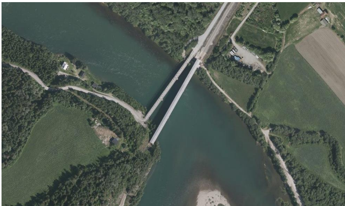
Figur 2: Eksisterende veg- og jernbanebru, med jernbanebrua til høyre. Jernbanebrua er kollapset, og vegbrua er sannsynligvis skadet.
