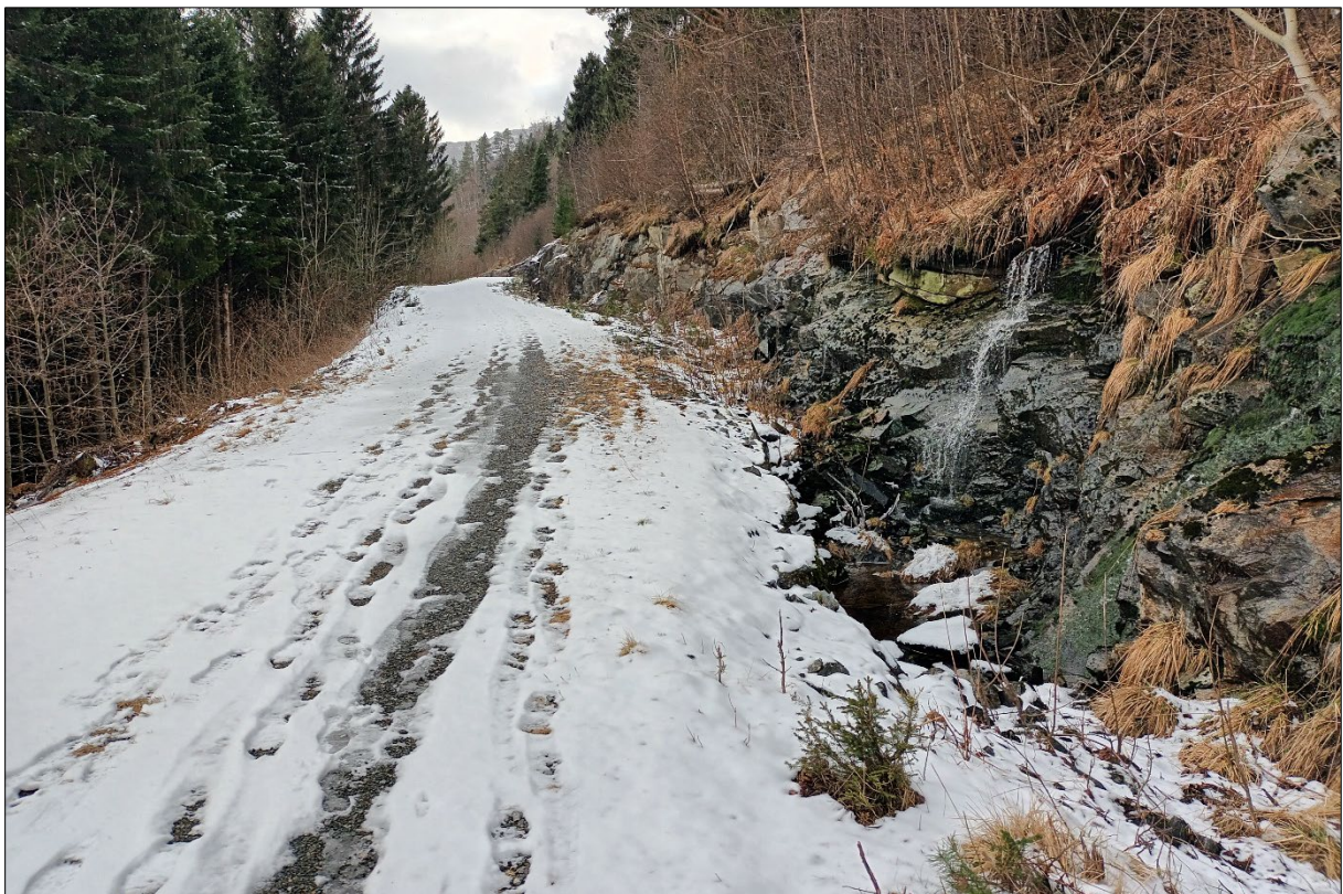
Figur 8: Bildet er tatt i midtre del av påvirkningsområdet langs eksisterende vei. Berggrunnen består av gneis og er inntil 2 m høy.
