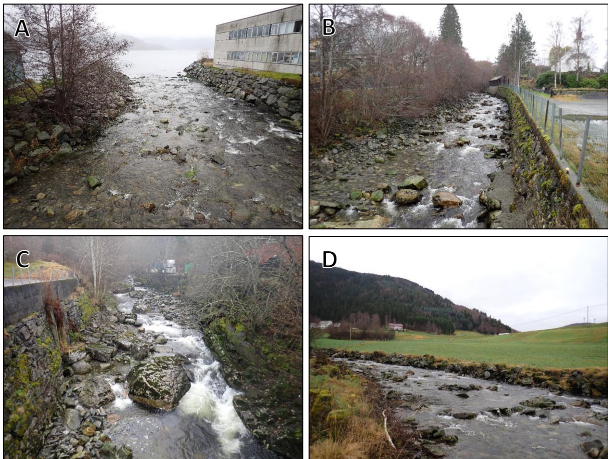
Figur 4. Inngrep i Stårheimselva: A) Nedre del av segment 1 er forbygd på begge sider og kantvegetasjonen mangler. B) I segment 2 er det forbygning på østsiden av elven, her mangler det også kantvegetasjon. C) Det er delvis forbygninger og lite kantvegetasjon i segment 4. D) I segment 8 er det forbygning på østsiden av elveløpet, og kantvegetasjonen mangler på begge sider av elven.
