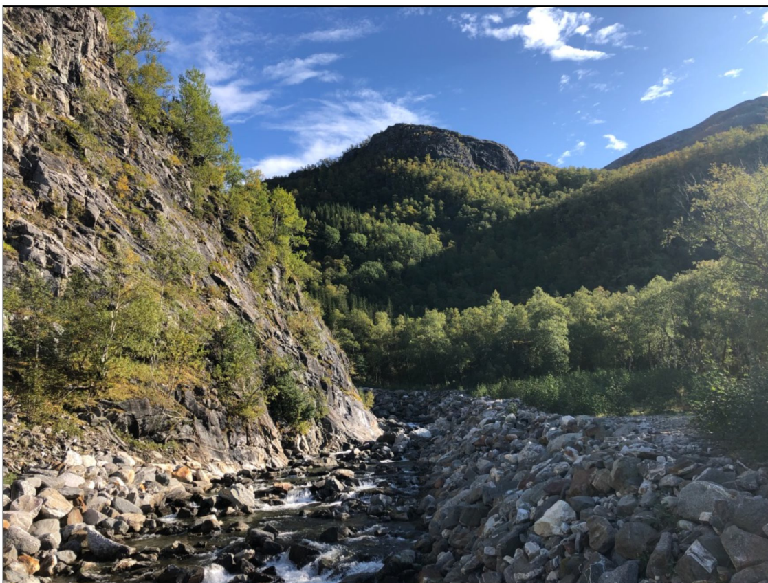
Figur 2.2. Nedre del av Skrovdalselva med forbygning.
