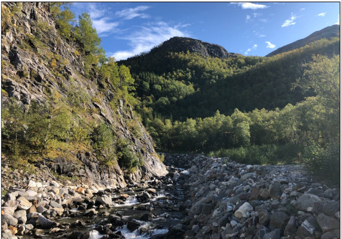
Figur 4.2. Forbygning langs nedre del av Skrovaldalselva. Traktorveien ses til høyre.
