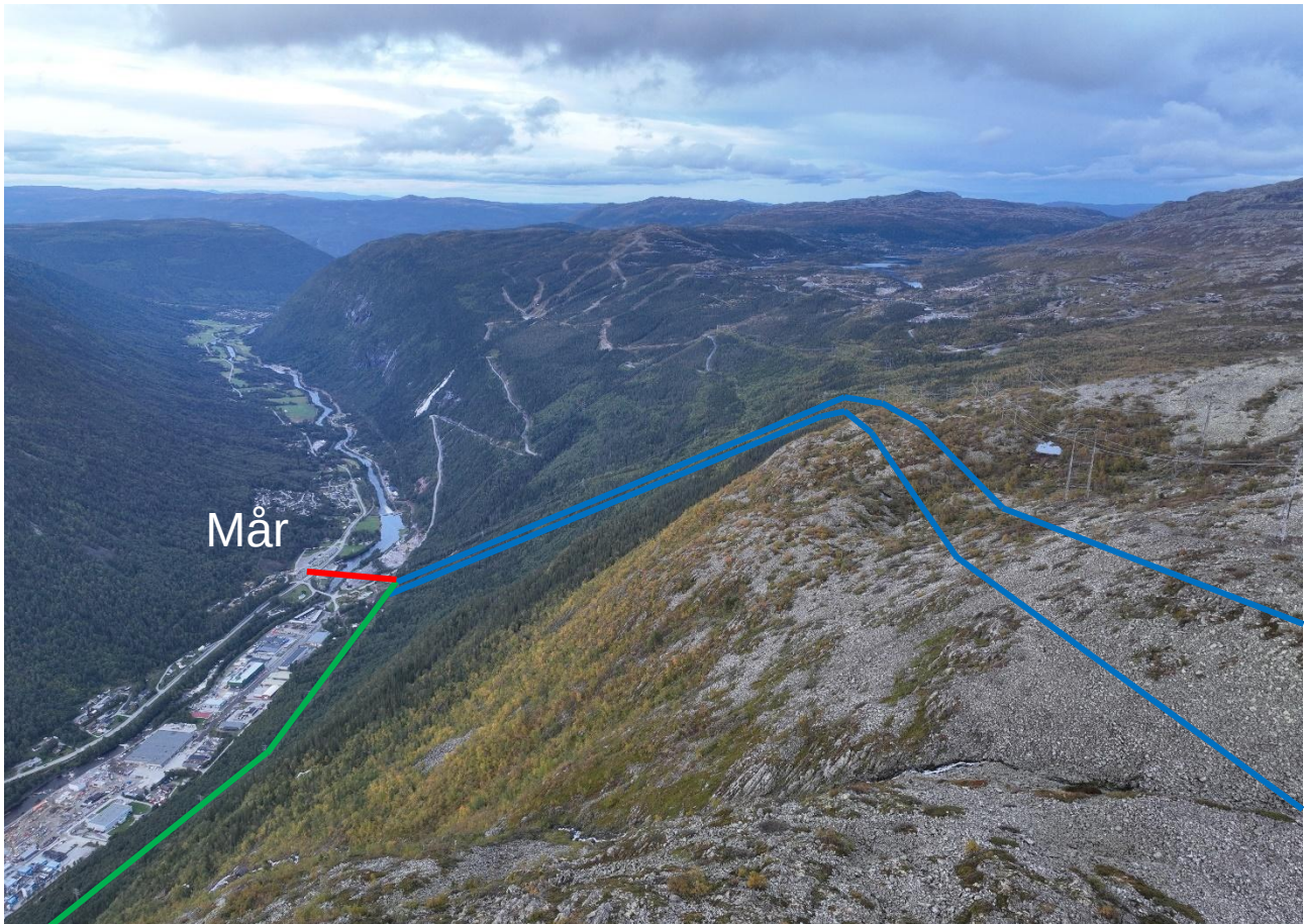
Figur 1-8. De nye 132 kV ledningene (blå linjer) går parallelt med Statnetts ledninger. De nye ledningene dreier mot nord og går ned fjellsiden mot Mår. Linjene er tegnet inn slik ledningen omtrent vil gå. Grønn linje viser eksisterende 132 kV Såheim-Mår, som vil rives. Rød linje viser strekning der eksisterende ledning beholdes.
