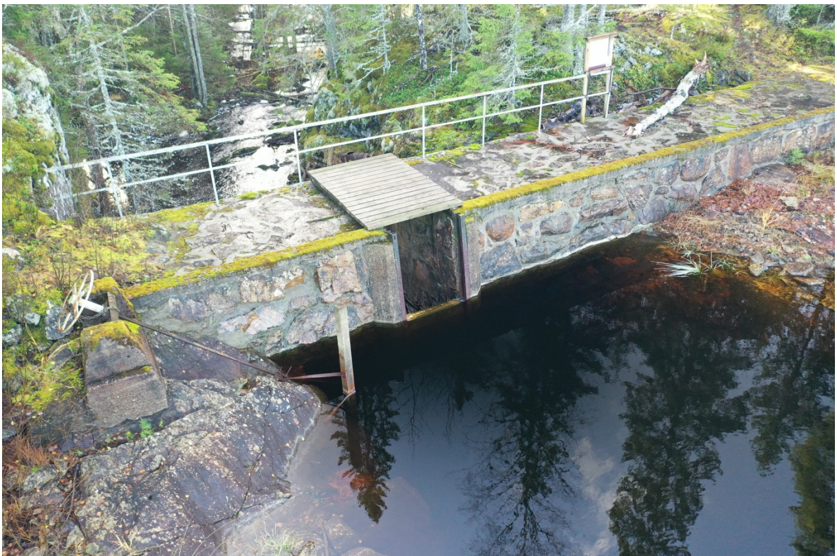
Risendammen. Hit gikk den første telefonlinja i Rødenes. Den var først og fremst satt opp for å kunne gi beskjed om å stoppe påslepp av mer tømmer, når tømmer hadde vaset seg nedover i elva under tømmerfløtningen. Foto: Ola Wergeland Krog 30.10.2021.
