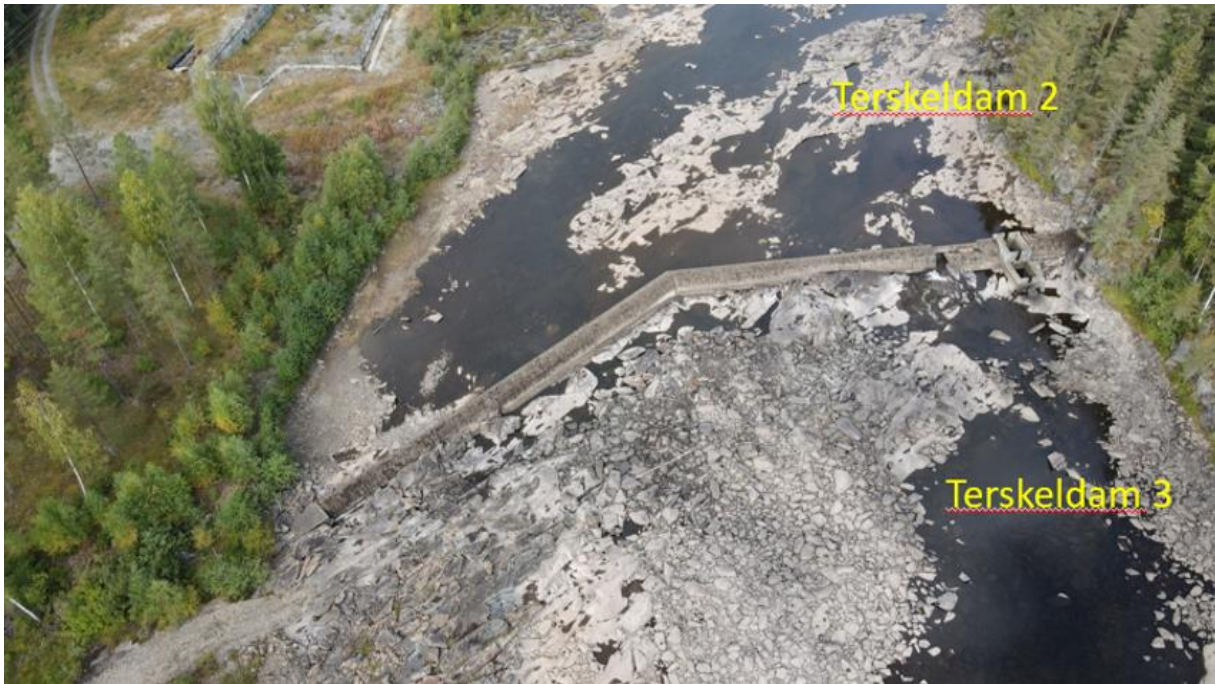
Terskelen mellom terskeldam 2 og 3. Fisketrappa gjennomterskelen sees helt til høyre. Like til venstre for denne er bjelkestengsel som åpnes for å senke vannstanden.
