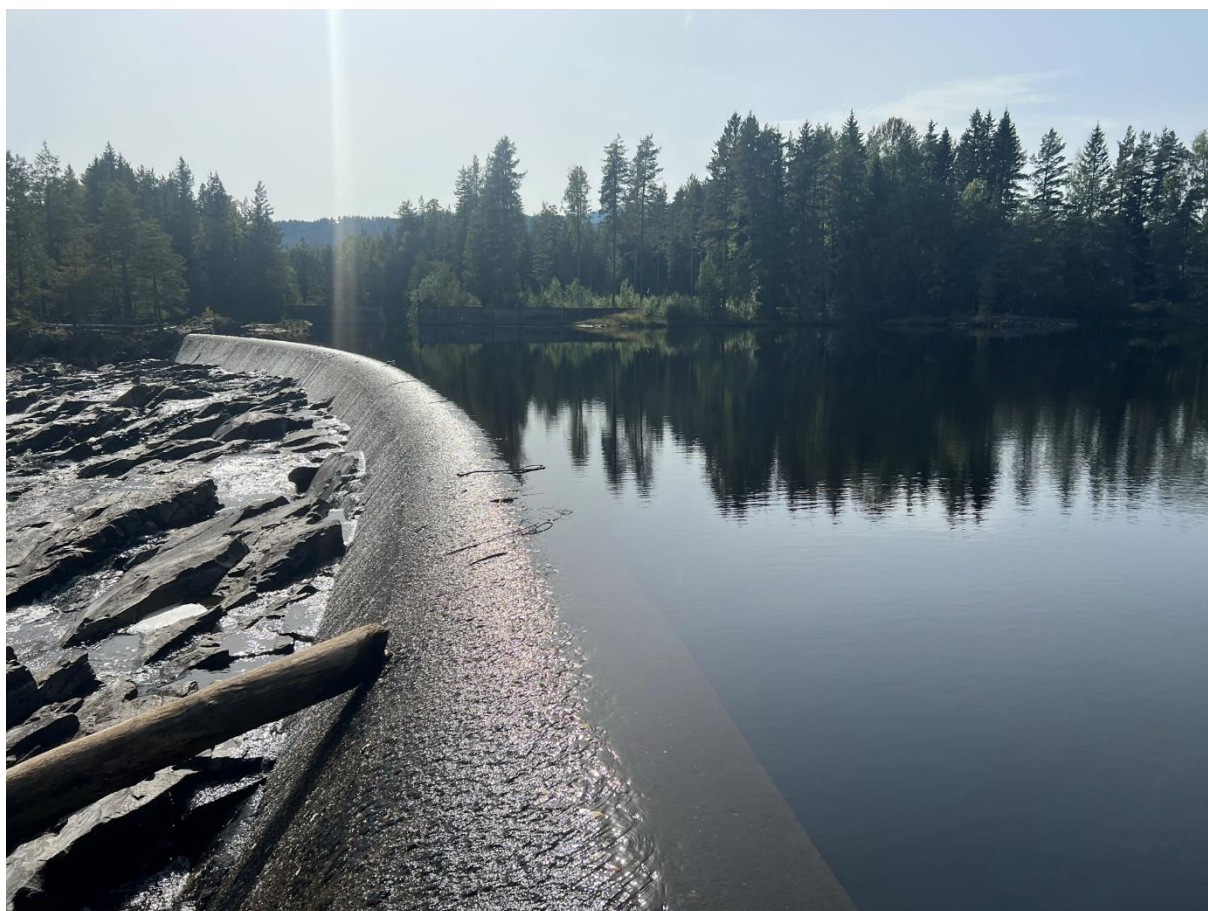
Terskeldam nr. 3. Bilde tatt fra østsiden av elva mot sør-vest. I prosjektet vil vannstanden i dette terskeldammen senkes ca. 1,5 meter.
