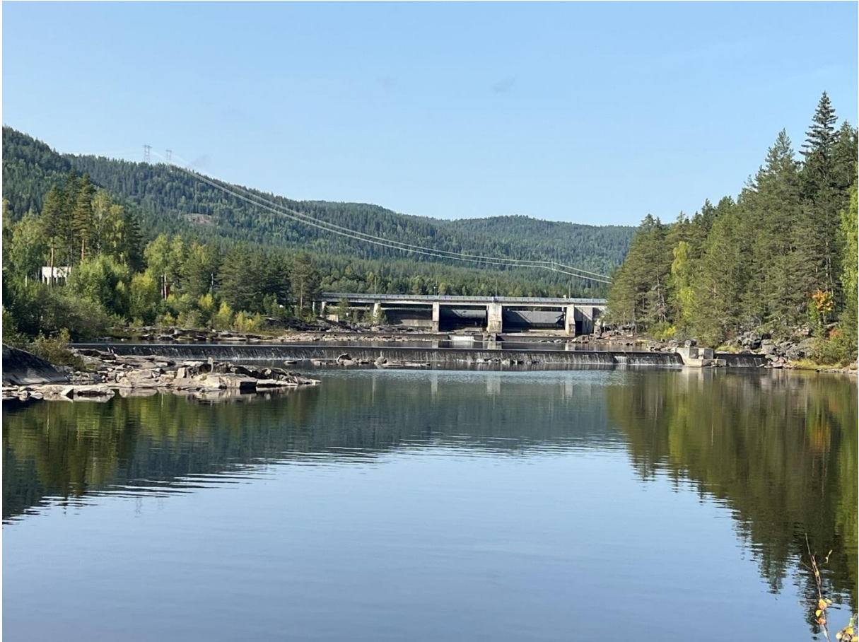
Øvre del av terskeldam nr. 3. Hoved-dam og de to tersklene ved terskeldam 1 og 2 sees i bakgrunnen.
