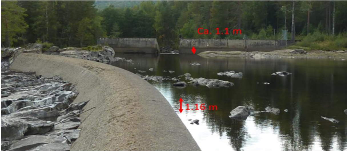
Terskeldam nr. 3. Bilde tatt fra østsiden av elva mot sør-vest. Terskelen i bakgrunnen danner skillet mellom terskelbasseng 3 og den lille terskeldam 4. Vannstandssenkingen er skrevet på bildet.
