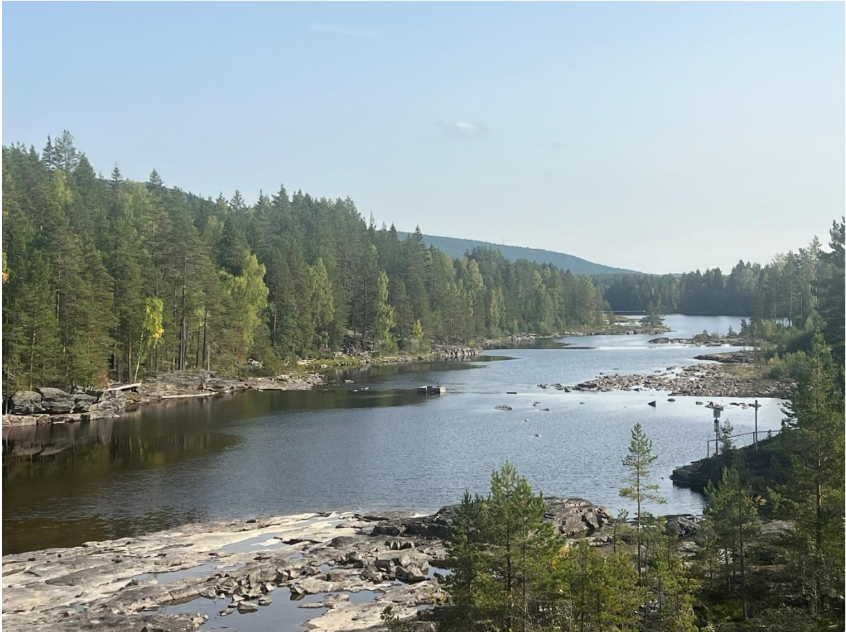
Terskeldam nr. 1. Bilde tatt fra hoved-dam i nedstrøms retning. Første terskel kan sees midt i bildet.
