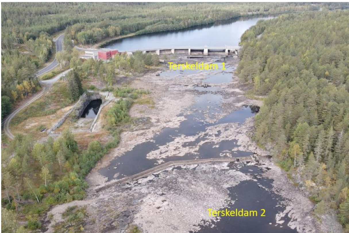
Øvre del av terskeldam 2 og hele terskeldam 1. Terskelen har tilsvarende trapp og bjelkestengsel som på terskelen mellom terskeldam 2 og 3.
