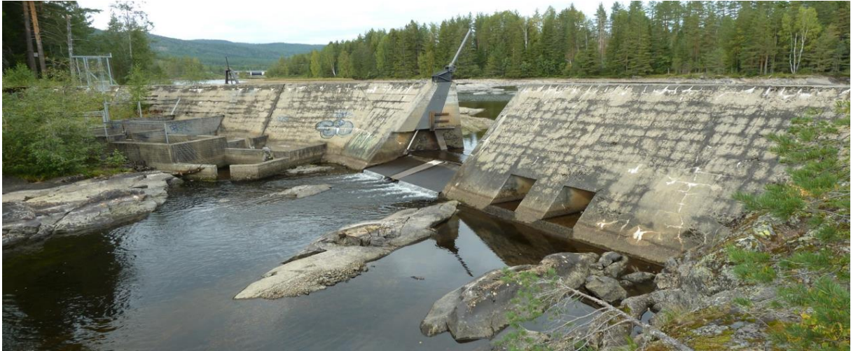
Terskelen mellom terskeldam 3 og 4. Tappeluka ligger helt nede på bildet. Fisketrappa sees til venstre i bildet.
