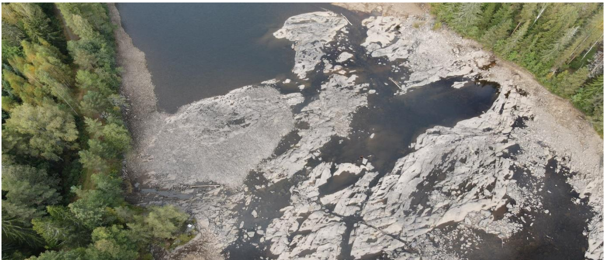
Nedre del av terskeldam nr. 3 når vannstanden er senket ca. 1 m.
