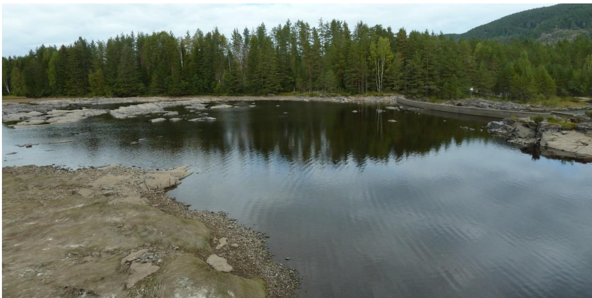
Terskeldam nr. 3. Bilde tatt i motsatt retning av bildet ovenfor.
