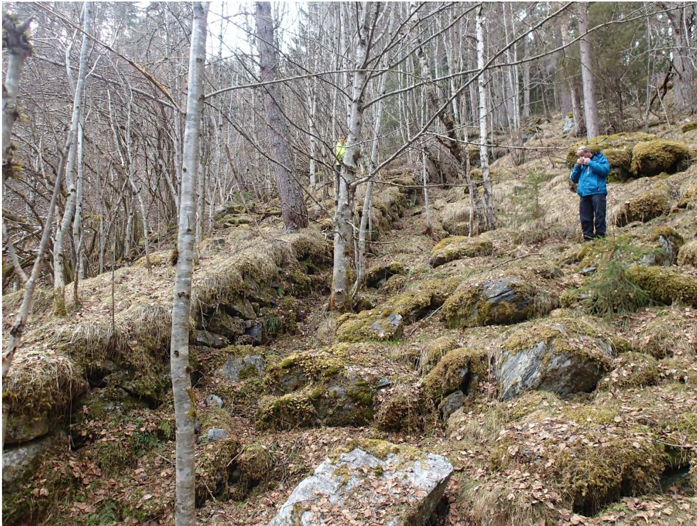
Bilete 1 Bilete viser den oppmura eksisterande rørtraséen tilhøyrande gamle Døsen kraftverk ved om lag PEL 300 (viser til figur 1). I dette området ser ein moglegheiter for å unngå konflikt med den gamle rørtraséen ved legging av ny rørgate.
