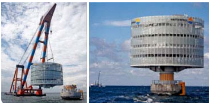
Bilder: Installasjon av transformatorplattform ved Lillgrund vindkraftpark Kilde: Vattenfall
