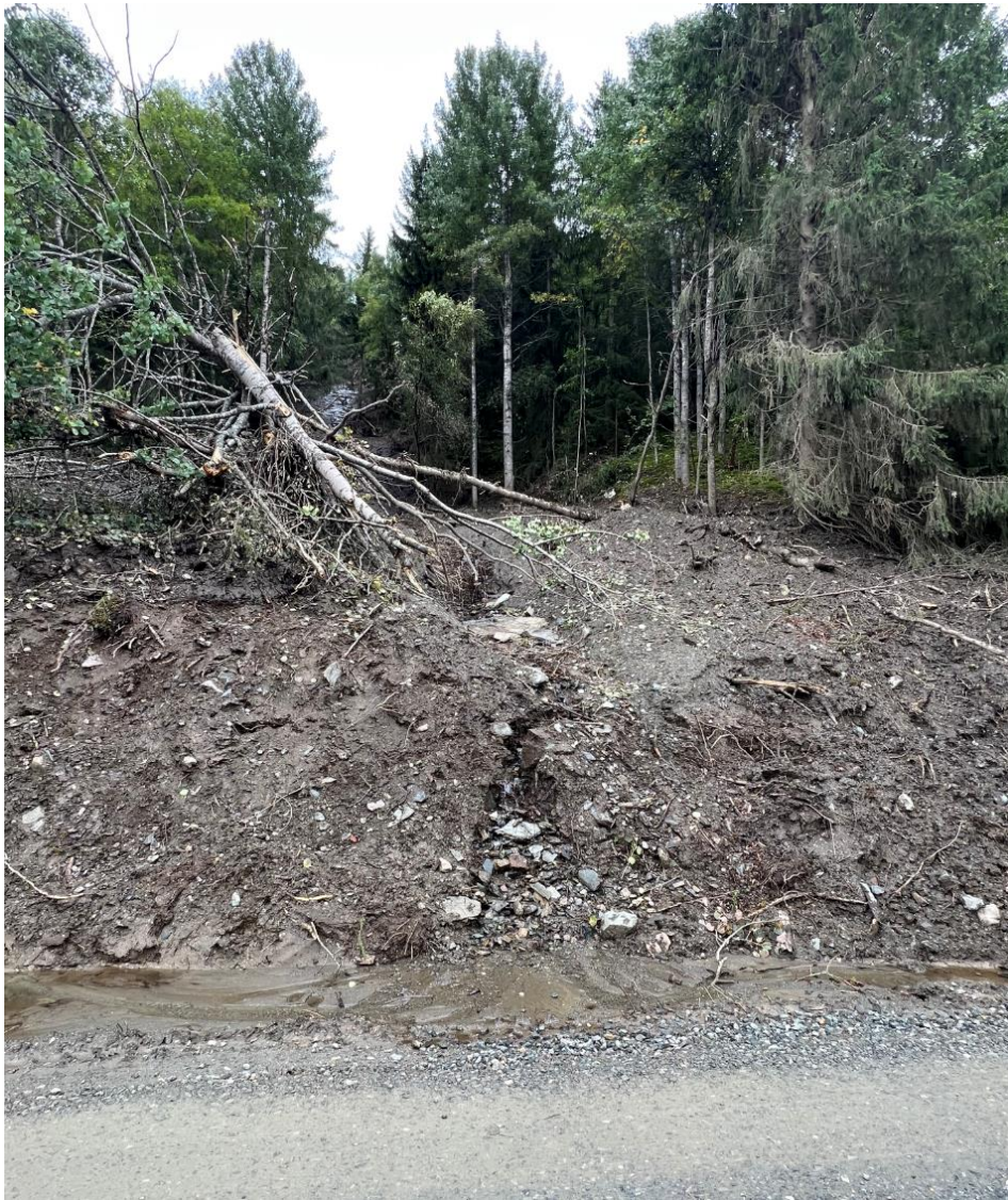
Figur 33. Skredløpet der det krysser veien like ovenfor huset.
