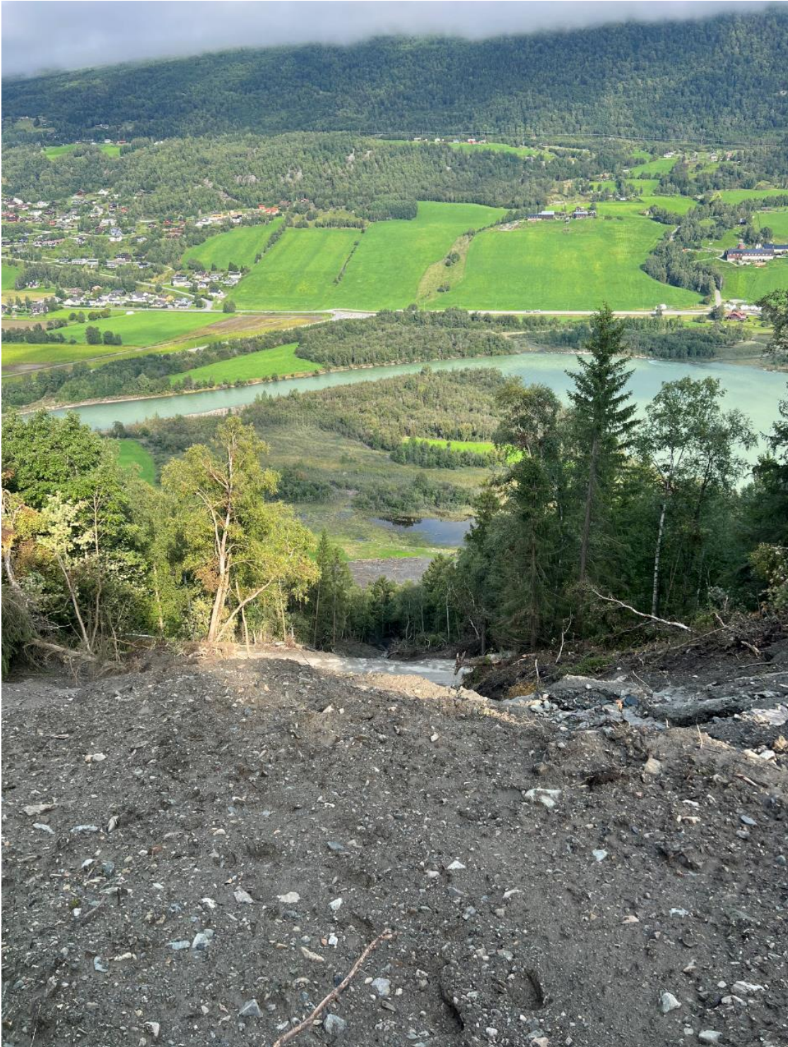
Figur 24: Bilde fra over fylkesveien.
