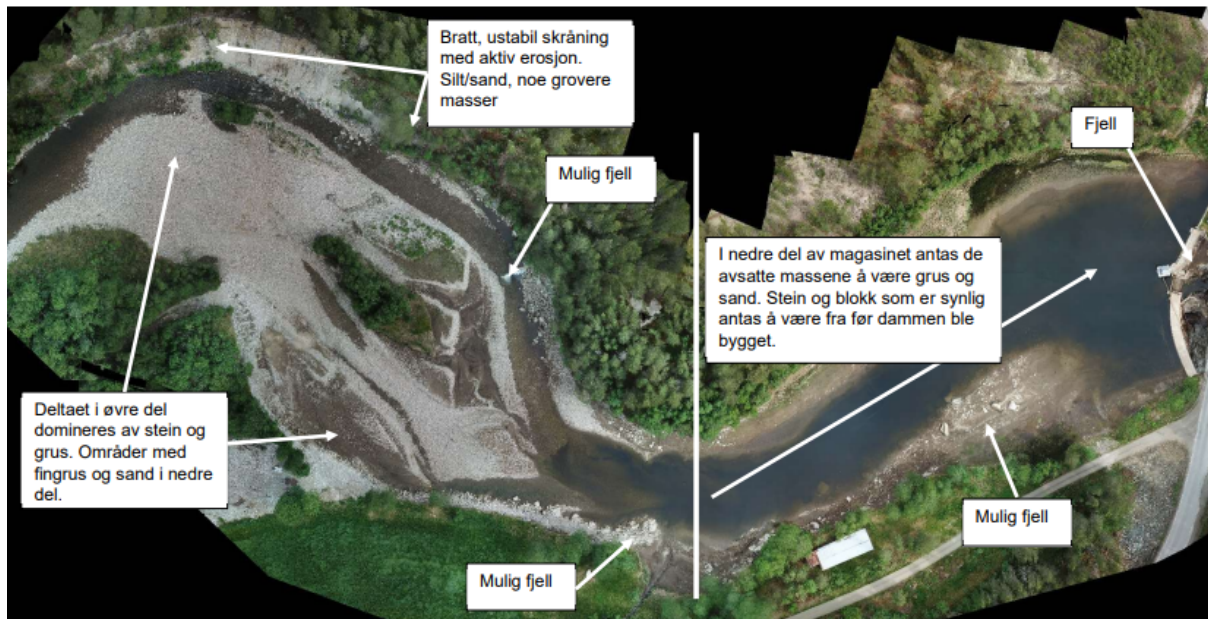
Figur 8. Dronefoto av inntaksbassenget med beskrivelse av avsatte masser. Sølnadammen ligger til høyre i bilde. Referanse: Norconsult (2021), vedlagt søknad.
