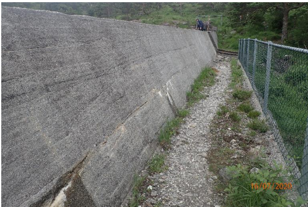
Bilde 10, tatt fra nedstrøms side mot sydvest
