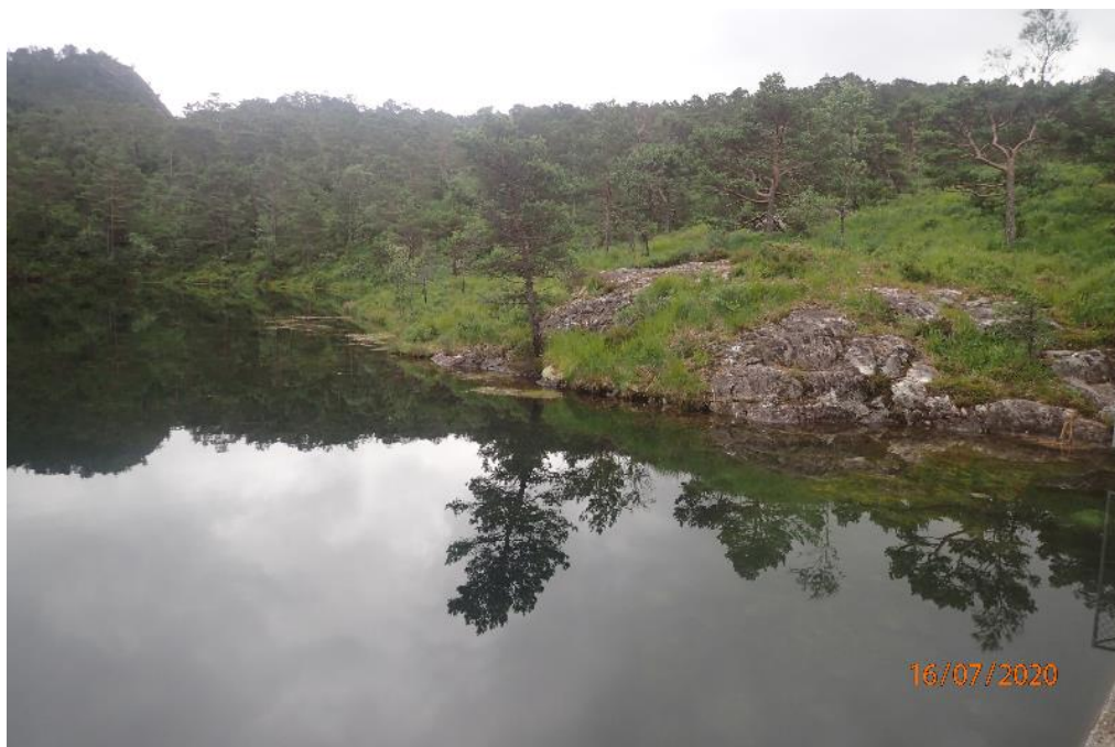
Bilde 1, tatt fra dammen mot syd
