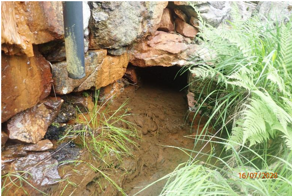
Bilde 11, nedstrøms dam, kulvert med ukjent funksjon
