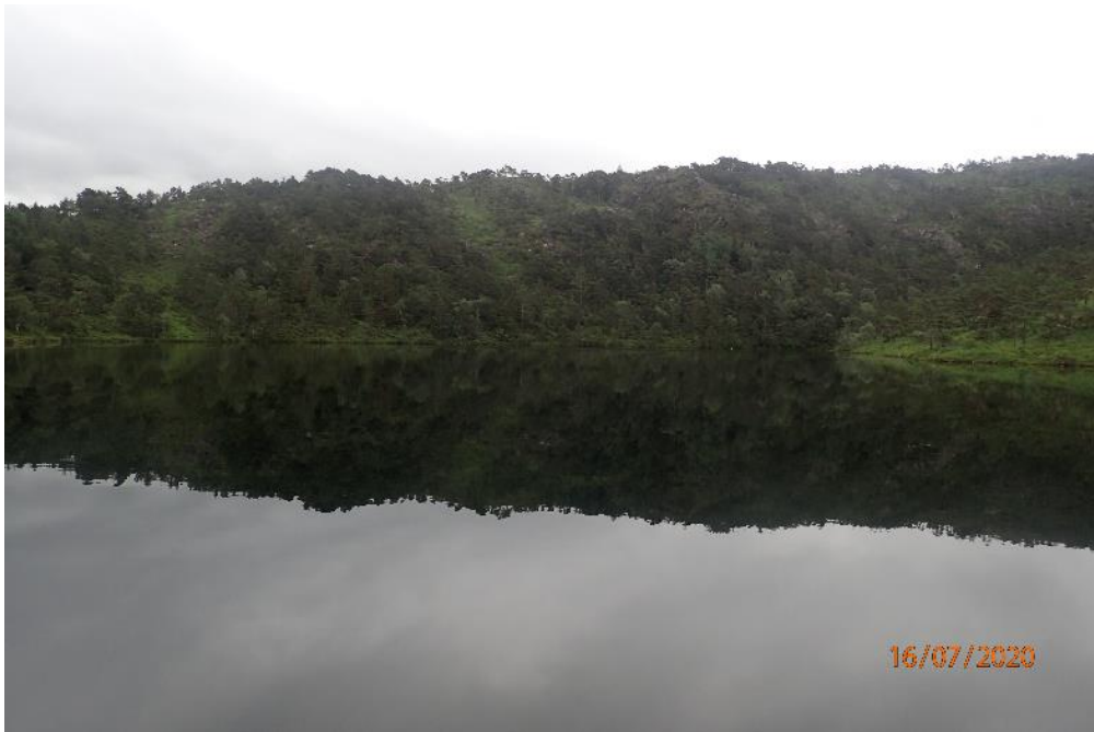
Bilde 3, tatt fra nordside av magasinet mot syd
