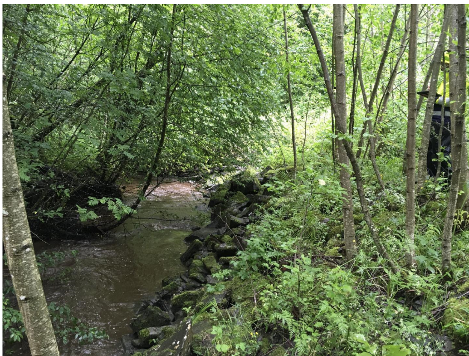
Figur 6-2 Bilde 1 Elven Leiråa er plastret med stor stein helt sør i kvikkleirsonen [6].
