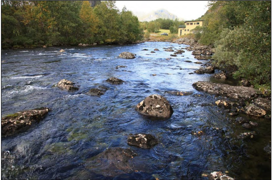
Figur 7. Stasjon 1, Grøndøla. Den gule bygningen i bakgrunnen er Brekkefoss kraftstasjon. Avløpsvannet kommer ut i elva rett utenfor denne.
