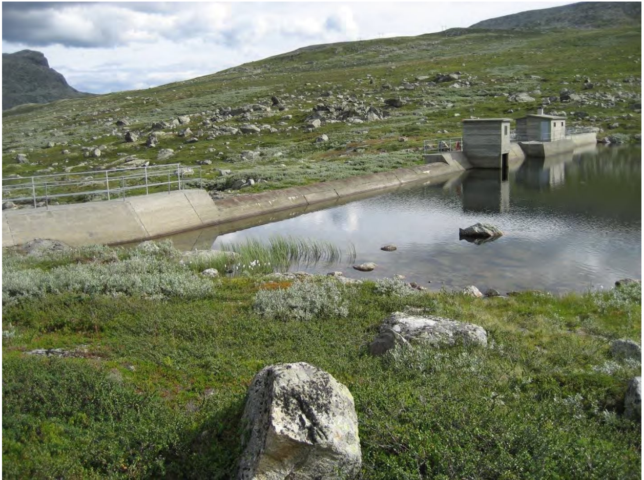
Inntak Dyrja. 19. august 2008
