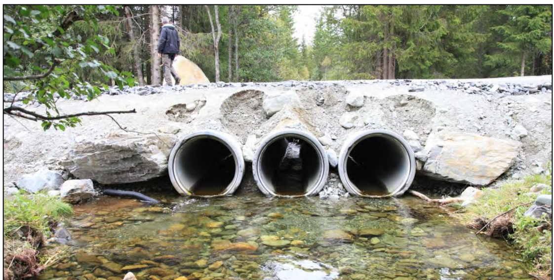
Figur 33. Kulvert i overkant av stasjon 1 i Dyrinja. Dreneringsgrøfta fra deponiet munner ut i venstre billedkant.
