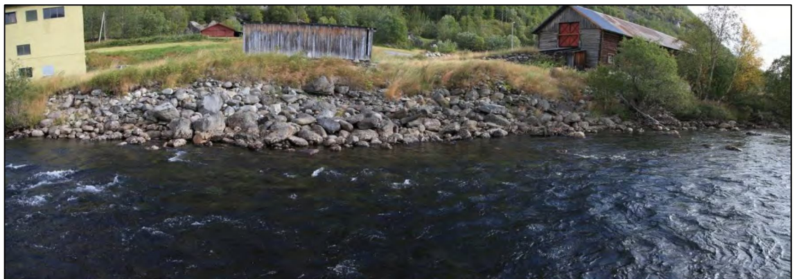
Figur 14. Parti fra Grøndøla ved Brekkefoss kraftstasjon (sees i venstre billedkant) med tydelig forbygning av elvebredden.
