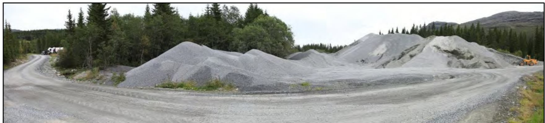
Figur 32. Midlertidig massedeponi ved stasjon 1 i Dyrinja. Dyrinja går i kulvert under veien i venstre billedkant.
