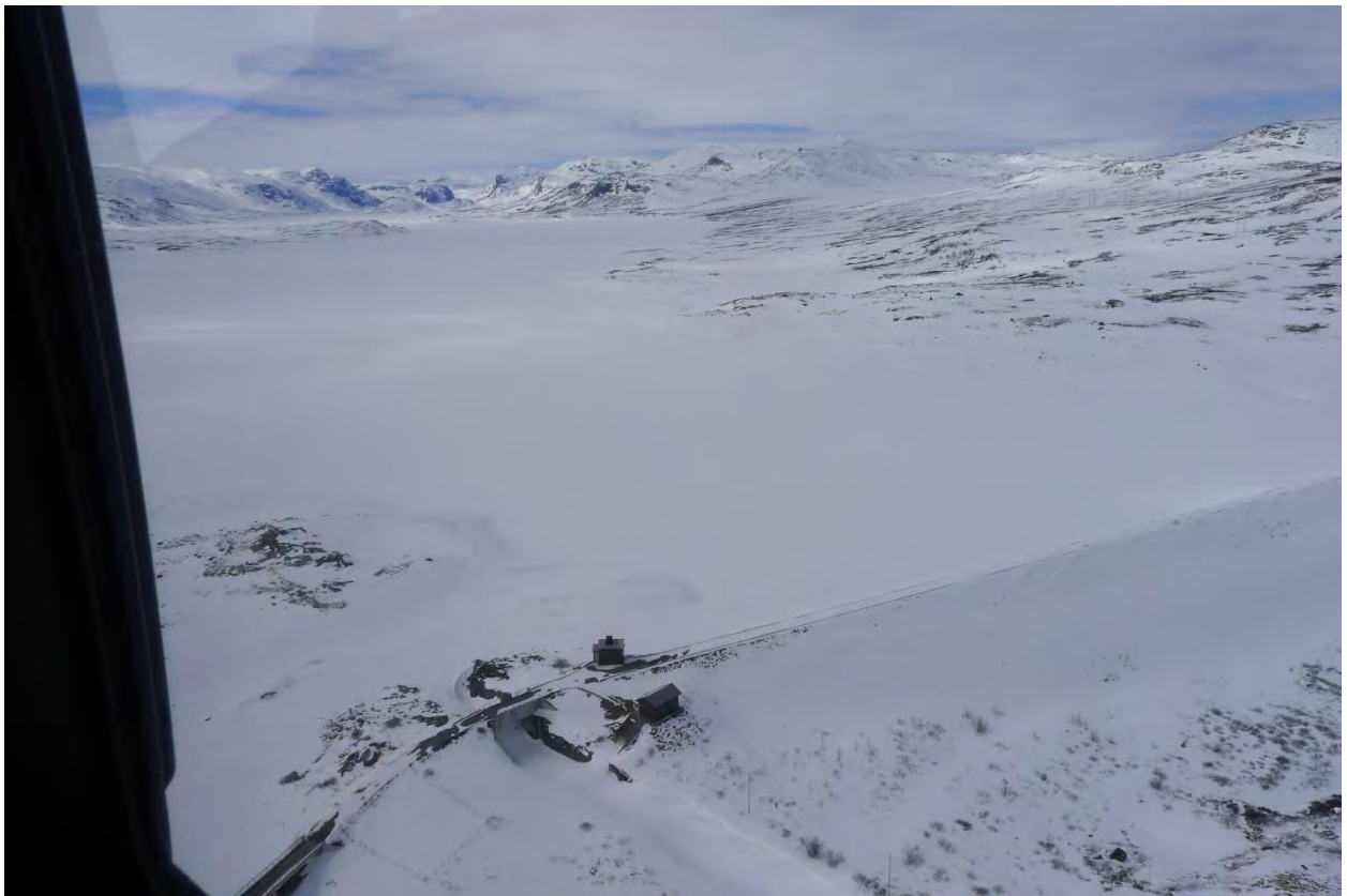
Dam Flævatn . 12. april 2012. Vannstand 1096,4.
