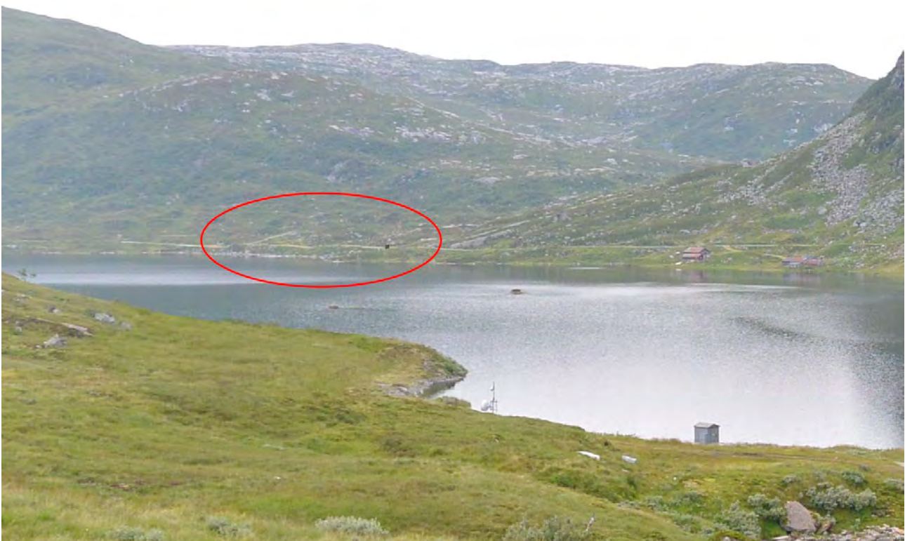
Figur 3-19. Nettstasjon Stordalen vist med rød sirkel, når sett fra dam Monsdalsvatn. I forgrunn er det det tilbakeført deponiet vest for dagen lukehus.
