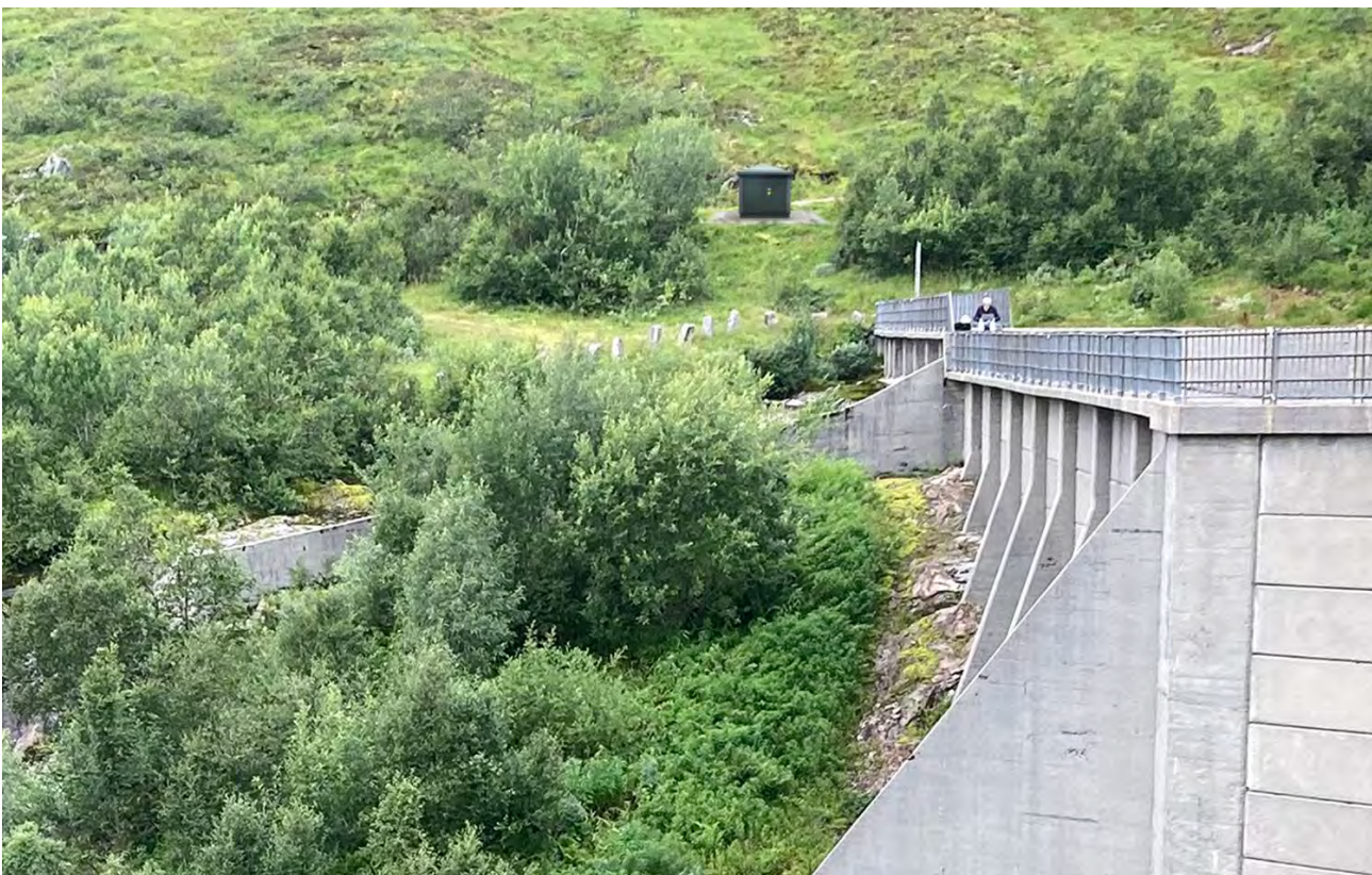
Figur 3-17. Nettstasjon Fossvatn, nærbilde under.
