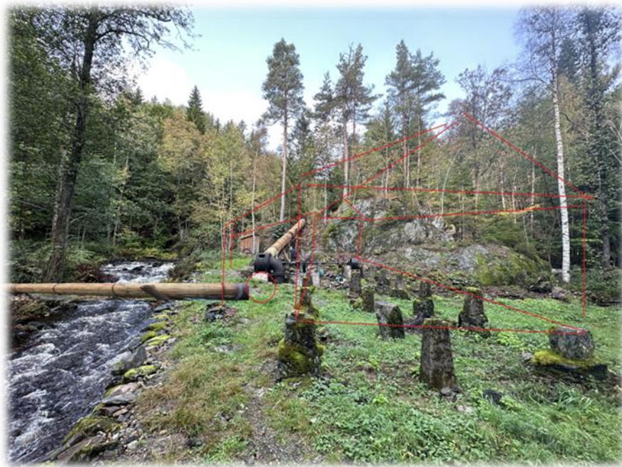
Bilde 21 Fundamentområde for gammel og ny Kraftstasjon
