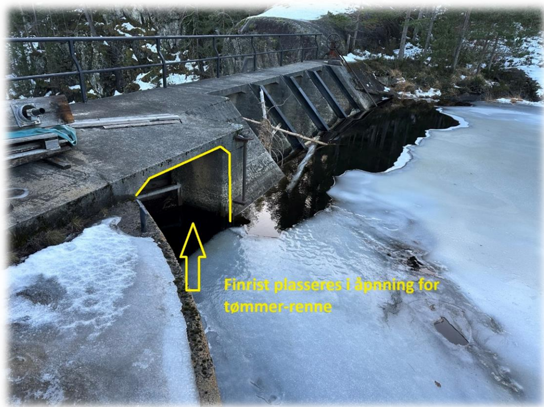
Skisse 5 Skisse inntakskonstruksjon
