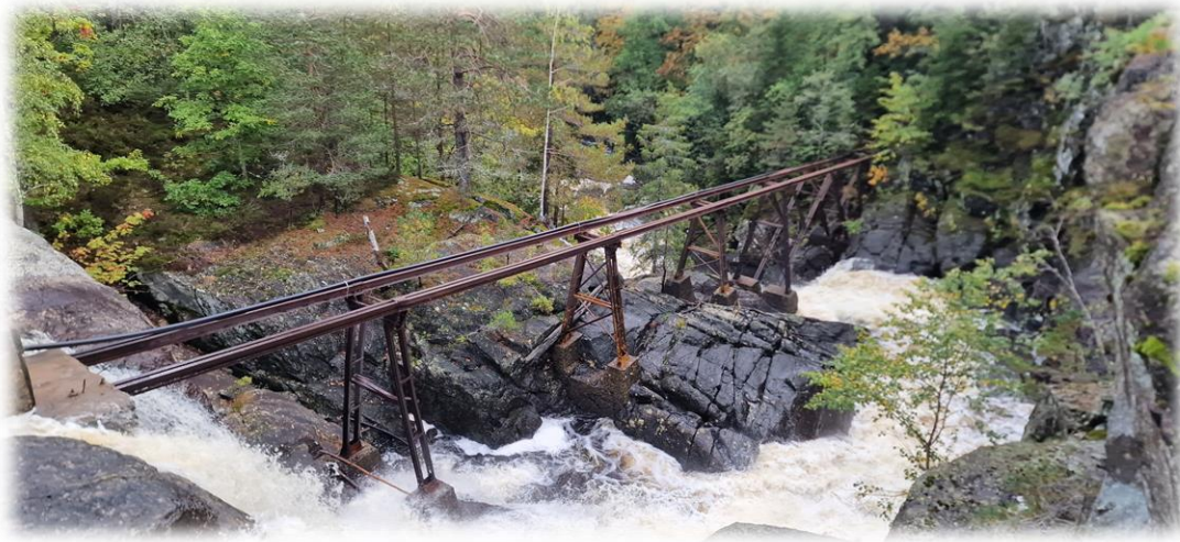
Bilde 7 Gammel konstruksjon for tømmerrenne
