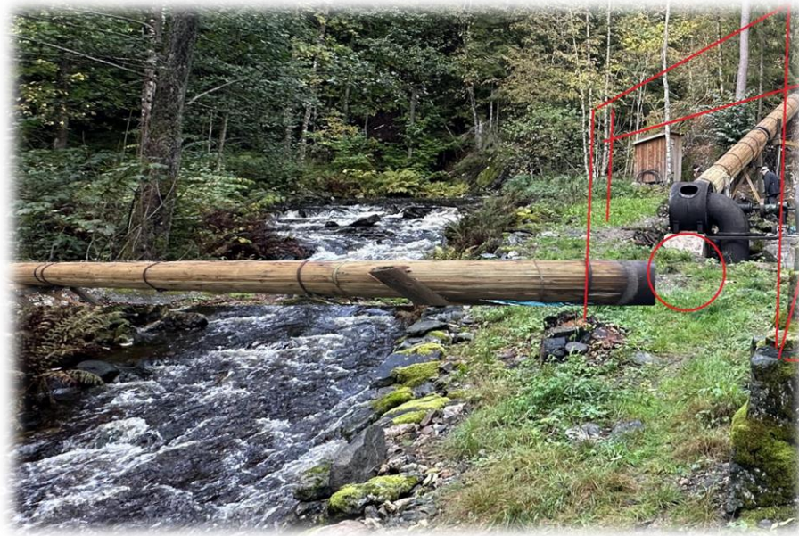
Bilde 20 Illustrasjonsbilde for nedre del av rørgaten i dagen
