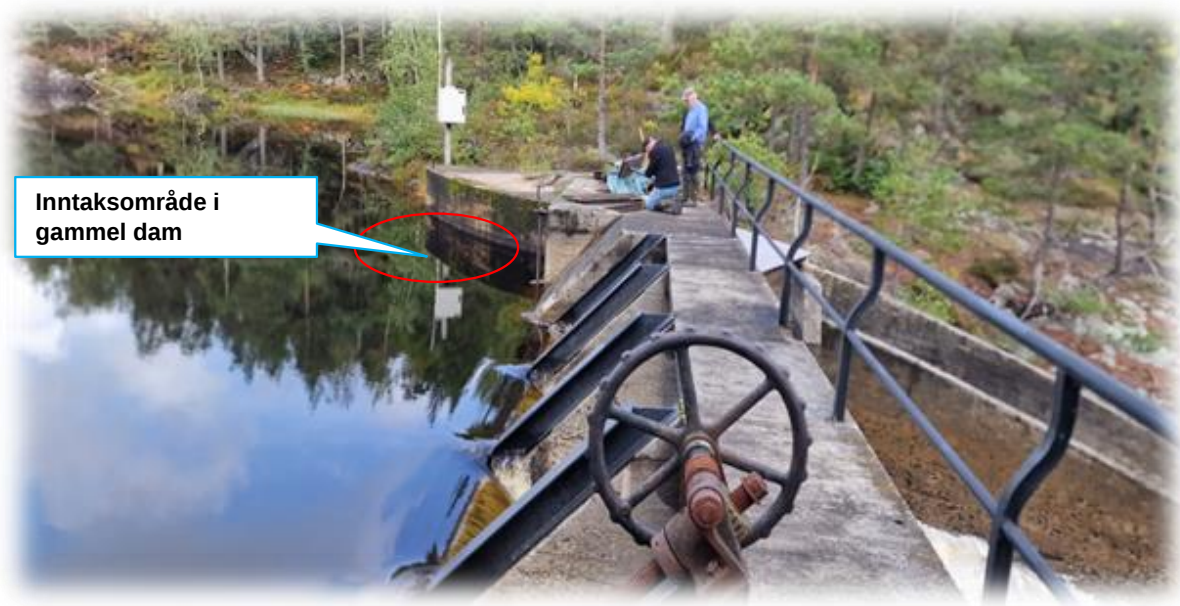
Bilde 15 Dammen hvor inntakskum med finrist planlegges
