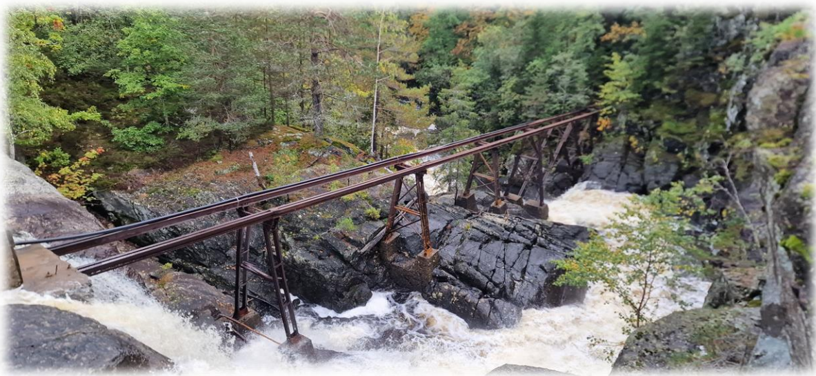
Bilde 15. Berørte strekning, sett nedstrøms dammen.
