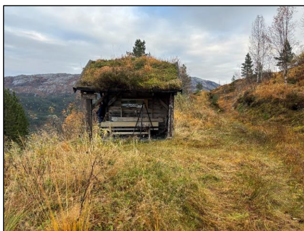
Figur 4-16. Nyautløa gapahuk. Foto: Sweco.
