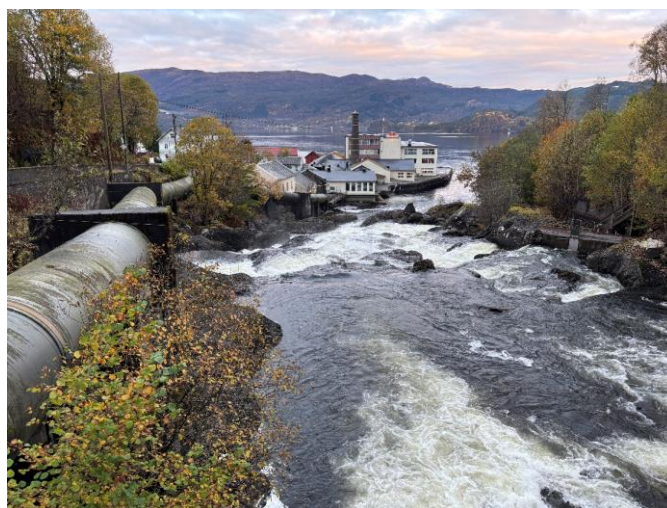
Figur 4-42. Venstre: Laksetrapp nederst i Tysseelva. Høyre: Nedre del av Tysseelva. Øvre avslutning på laksetrapp sees som betongkonstruksjon med luke helt til høyre i bildet. Foto: Sweco.
