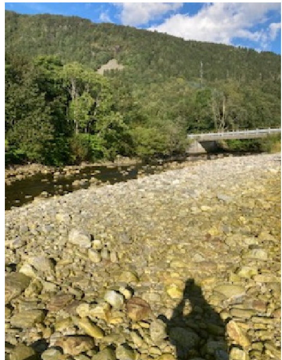
Ved osen mot brua.
