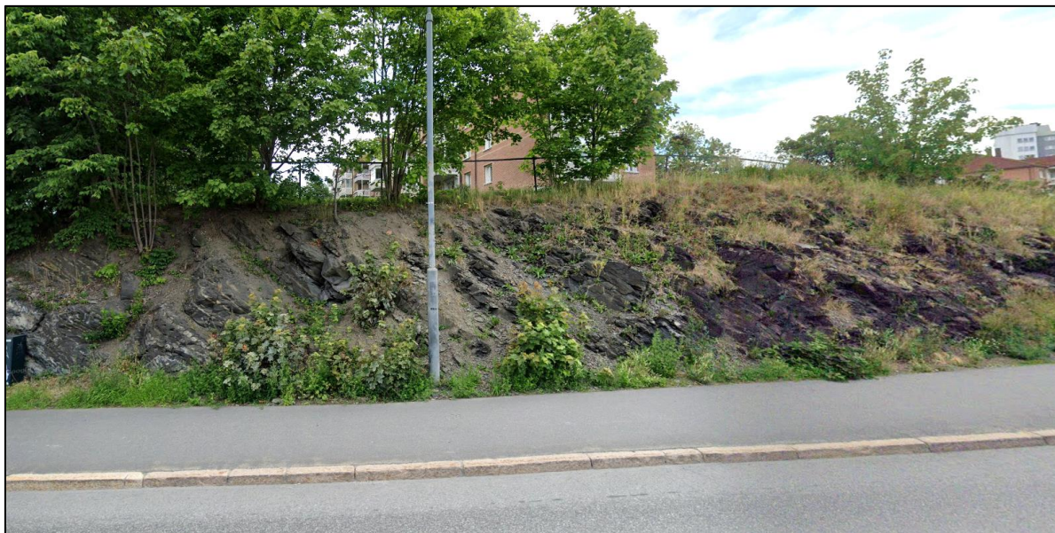
Figur 6-11: utklipp fra Google Street View, som viser bergskjæring.
