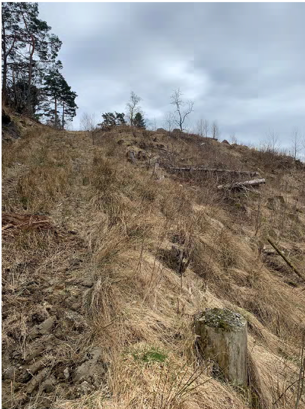
Rørgaten følger øvre kant i bildet langs grusvei for å unngå et noe skredutsatt område der bildet tas fra.
