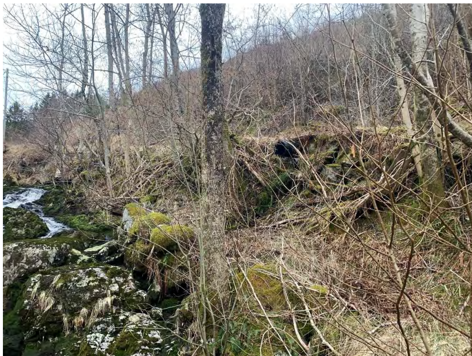
Kraftstasjon planlagt til høyre for eksisterende skogsvei som sees på bildet når en ser oppover vassdraget fra sjøsiden
