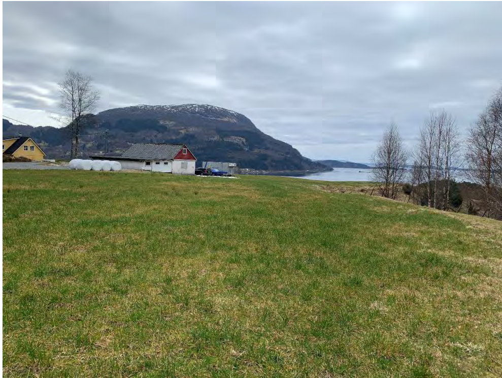
Venstre side av bro med innmarken til tiltakshaver og verkstedet til venstre. Rørgaten vil graves ned i grøft over innmarken midt i bildet.
