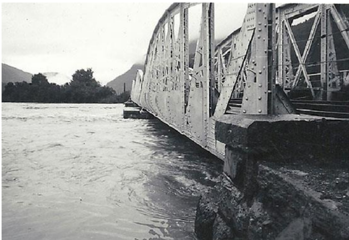
Figur 1-6. Historisk bilde av Otta jernbanebru under flommen i 1938 [3].
