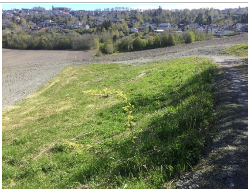
Dagens situasjon før anleggsveg ved profil 150 og videre mot renseanlegget
