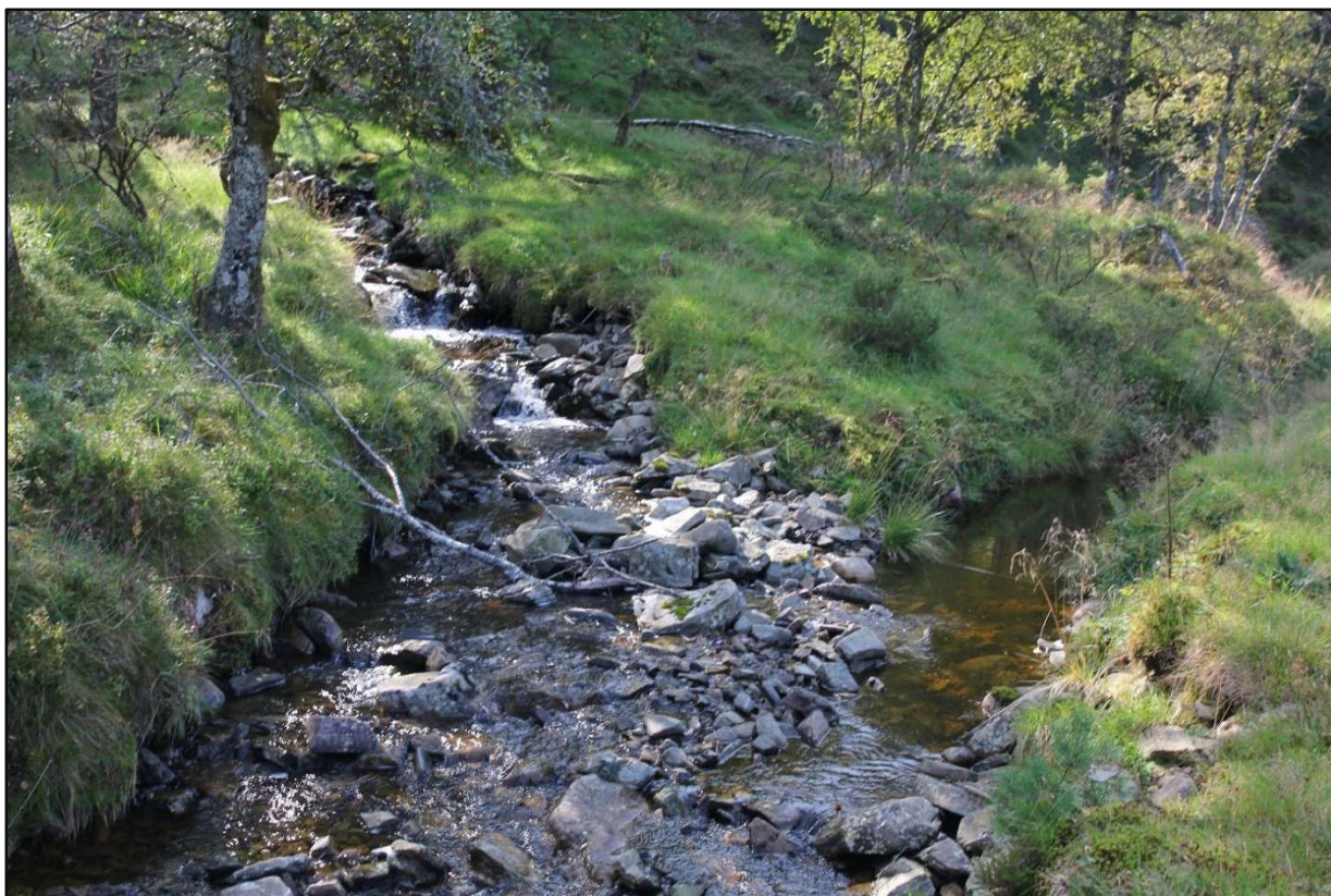
Bekken mellom Langavatnet og Myrkavatnet møter kanal, ca. kote 374, 1. september 2023:
