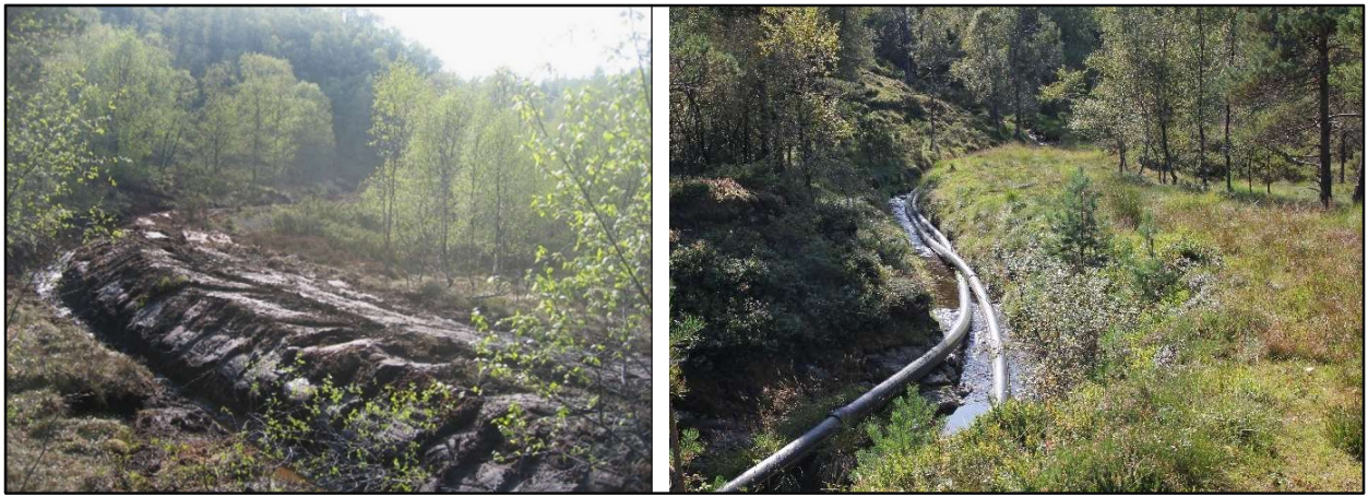
Figur 14. Overføringskanalen vil ha likskap med kanalen som i 2009 (til venstre) blei bygt inn mot Myrkavatnet frå vest. Tilgroinga av terrenget same plass i 2023 (til høgre) er merkbar. PE slangane er no fjerna frå staden.
