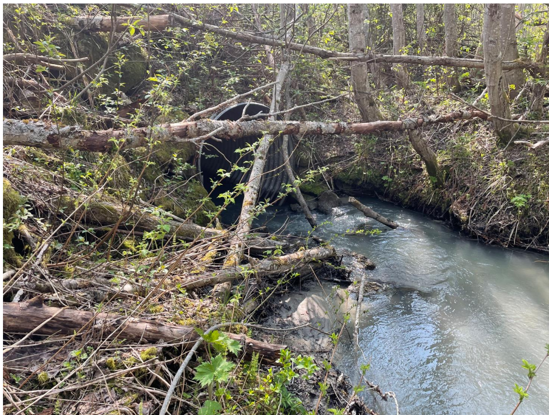
Figur 5.6 Bilde J02. Kulvert
