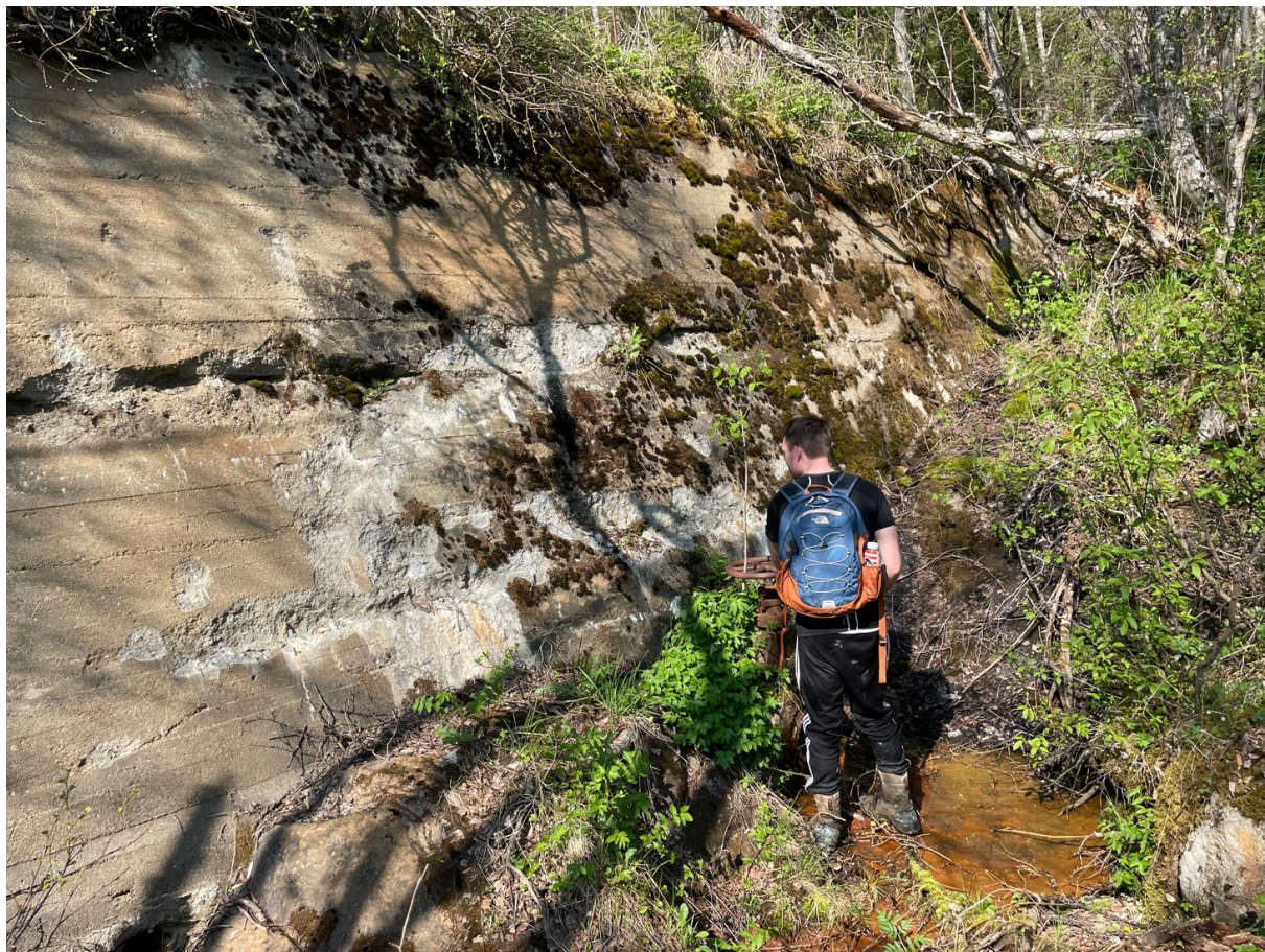
Figur 5.16 Bilde J217. Demning fundamentert på berg
