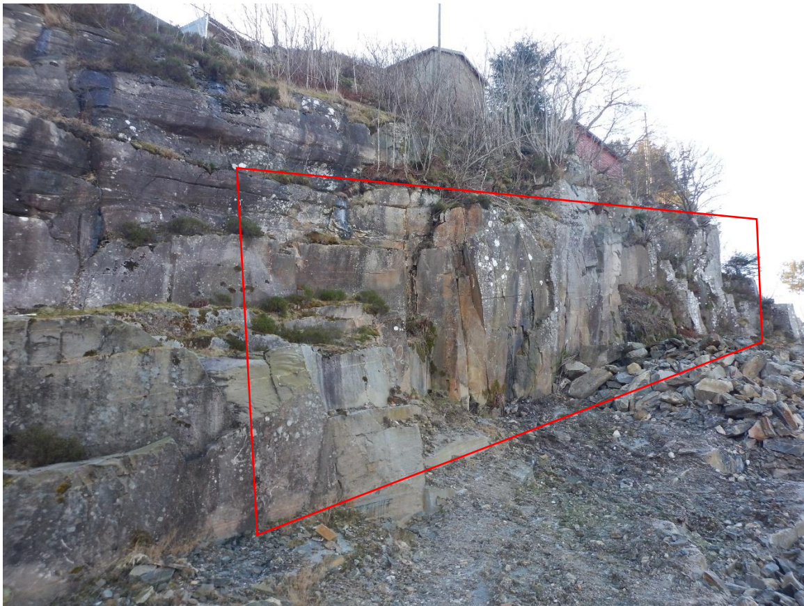
Figur 14: Bilde som illustrerer overgangen mellom berggrunn som er lite eller ikke påvirket av menneskelig aktivitet, til områder som er påvirket av sprenging (rødt omriss), nedafor Hanøyvegen 501. Bildet er tatt mot sørvest.
