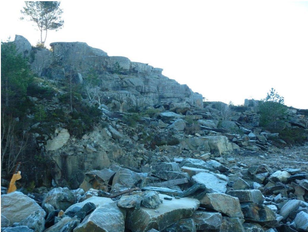
Figur 7: Slakt skrentparti som er noe oppsprukket, trolig som følge av sprenging. Bildet er tatt nord for Hanøyvegen 503, mot vest.
