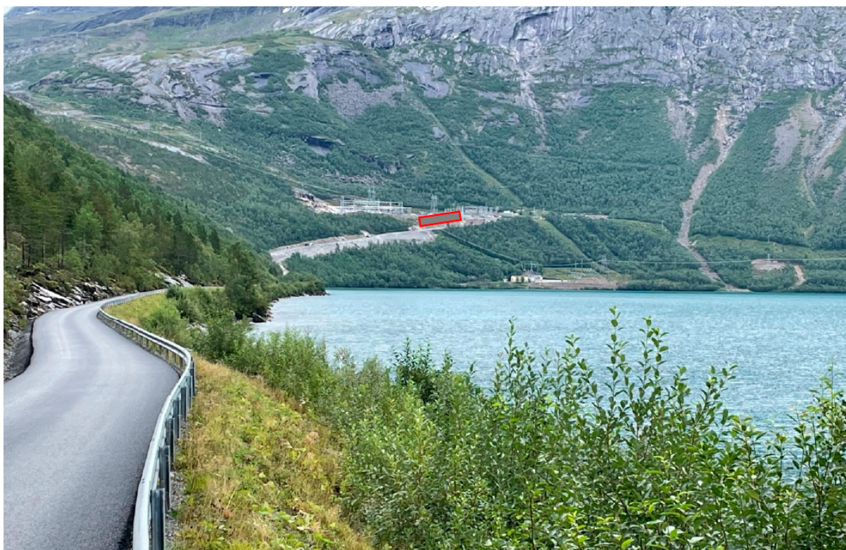
Figur 2: Illustrasjon av tiltaksområdet på Salten transformatorstasjon, sett fra adkomstveien langs Straumvatnet. Kilde: Statnetts søknad
