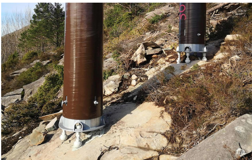
Figur 6. Eksempel på ståladaptere fra Comrod sine nettsider ( www.comrod.no/fundamenteringen ).
