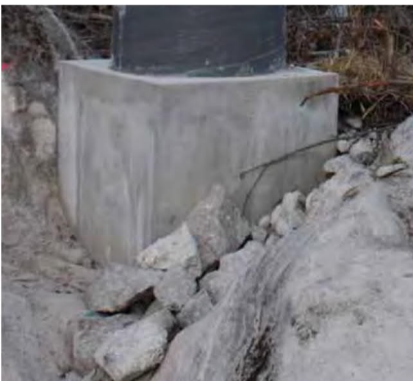
Figur 4. Eksempel på fjellfundament
