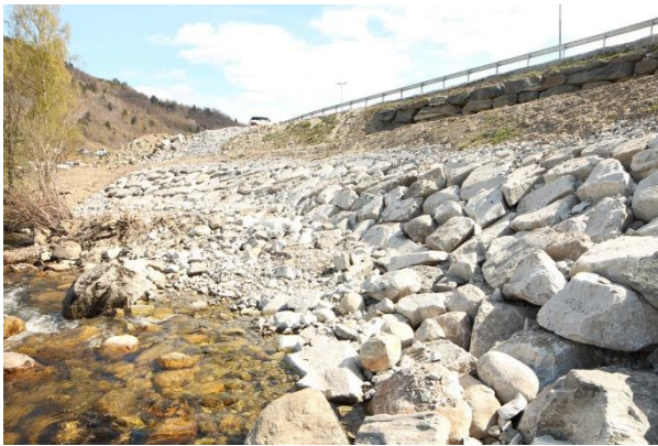
Figur 1. Eksisterende plastring sett ovenfra (venstre) og nedenfra (høyre). Overflaten er relativt ru i øvre del og er hele veien trukket noe inn ved normal vannføring i elven. Enkelte steder er noe av kantvegetasjonen bevart foran plastringen.
