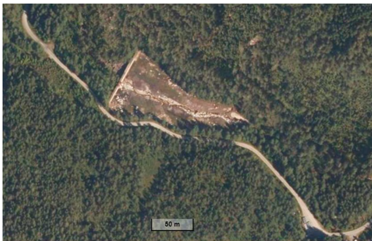
Figur 1: Foto av Bjørkedalsdammen i nedtappa tilstand. Bildet er henta frå søknaden
