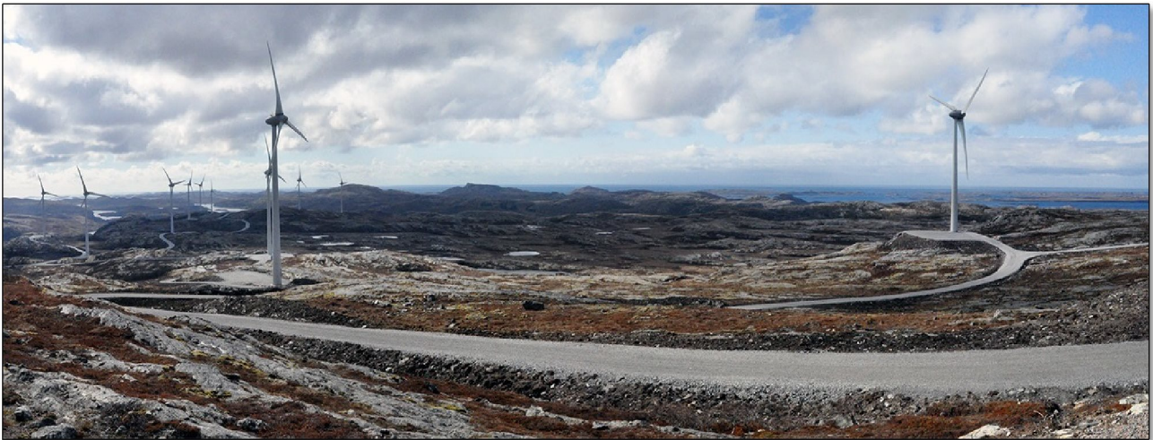
Figur 19. Panoramabildet viser kranoppstillingsplasser som generelt ligger godt i terrenget, med unntak av den ved vindturbinen til høyre i bildet som ligger noe høyt og blir dertil eksponert.
