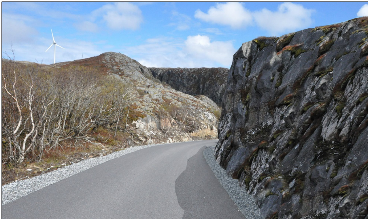
Figur 15. Manipulert bilde som viser en tosidig skjæring der det ikke er gjort tiltak for å dempe den visuelle virkningen av skjæringen til høyre i bildet.
