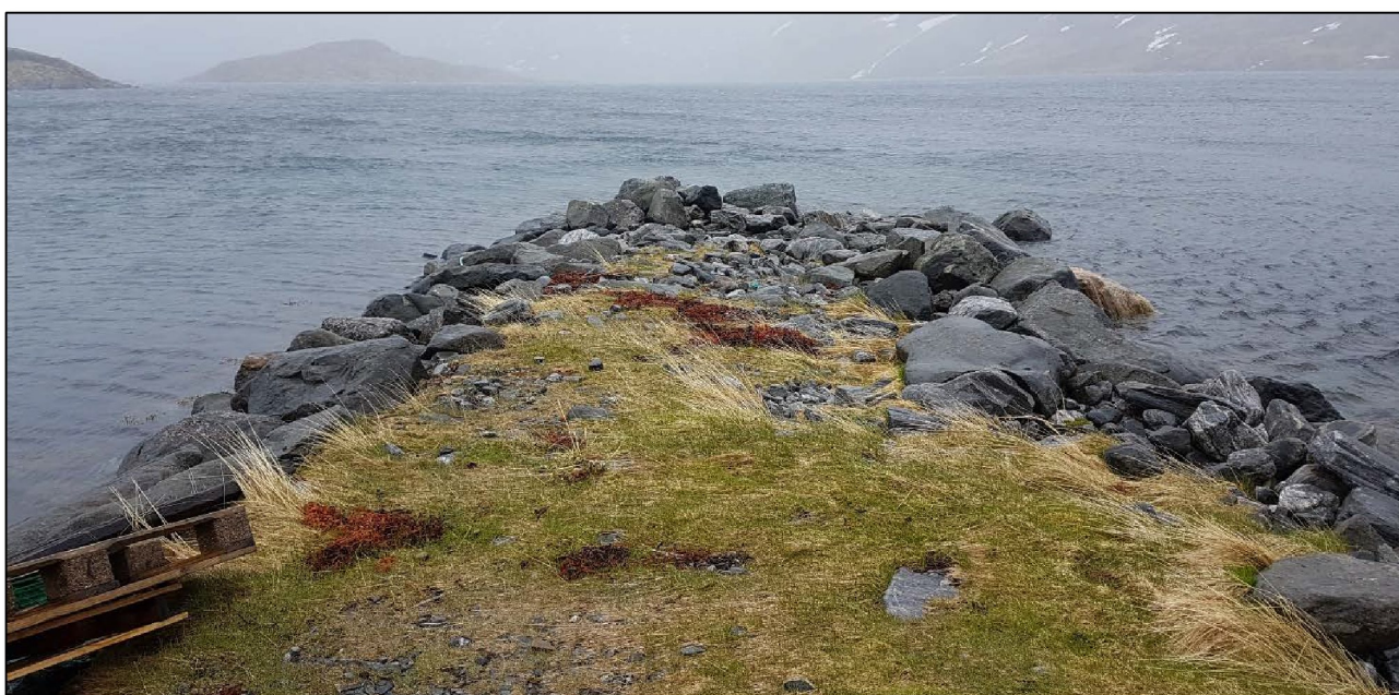
Figur 8. Eksisterende molo ved Elvestrand i Dønnesfjord. Moloen må utvides til ca. 6 m og forlenges med noe for kunne føre i land turbiner, transformatorstasjon og anleggsmaskiner. Utførelsen vil bli i betong eller stein.
