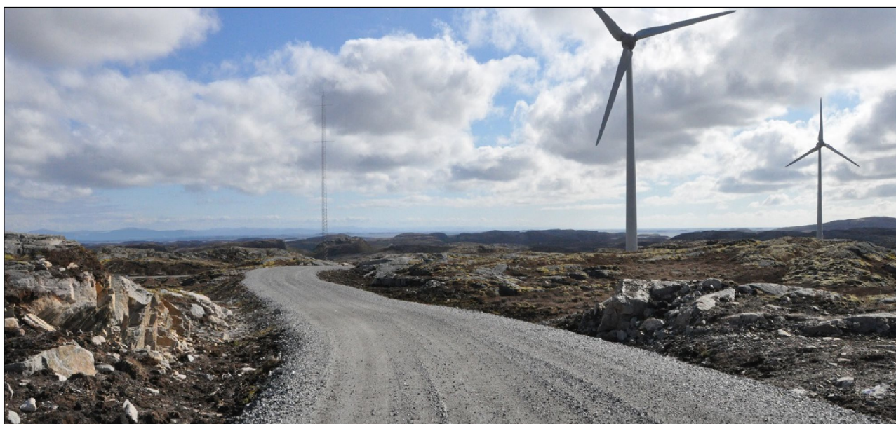
Figur 18. En mindre skjæring står igjen på venstre sida av vegen. Mindre pigging i toppen, som vist på manipulert bilde nederst, er alt som skal til for at oppstikkende nabber på begge sider av vegen skal bli mindre påfallende.
