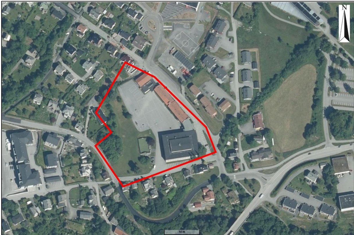
Figur 5: Flyfoto over området for grunnundersøkingar for ny ungdomsskule i Volda. Tomta ligg i tettbygd strøk, og har lite vegetasjon.
