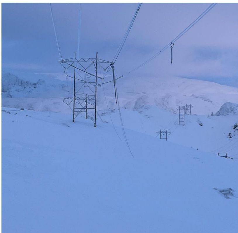
Figur 7: Bilde for illustrasjon (Sima-Samnanger). Bildet viser at topplinen til høyre har røket. Topplinen til venstre er sterkt nediset.
