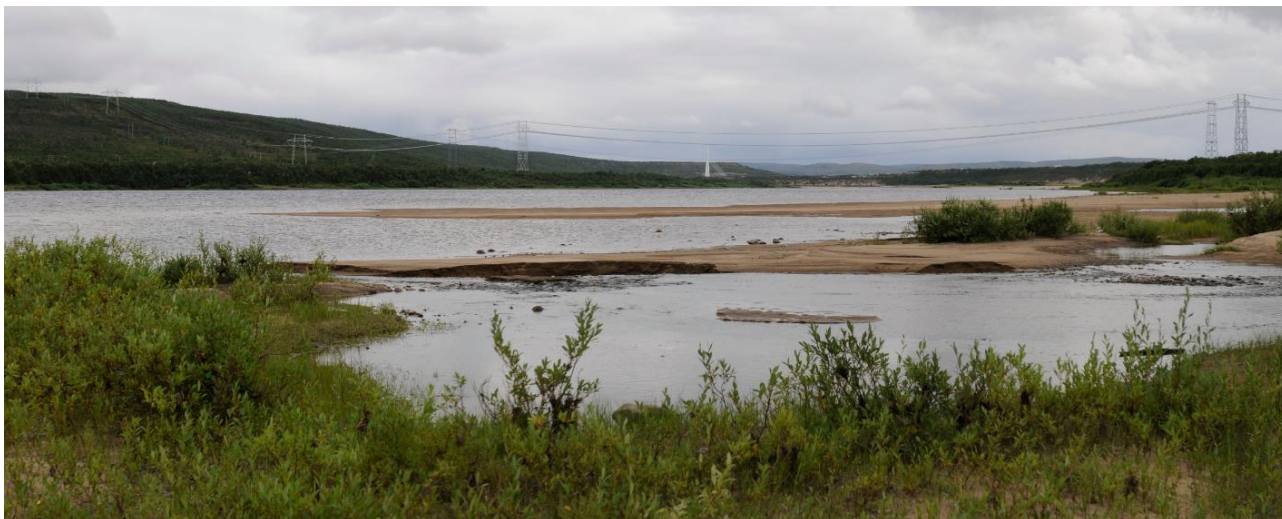
Figur 4-43 Visualisering av nytt spenn (420 kV) over Tanaelva. Det går parallelt med eksisterende 132 kV-ledning.
