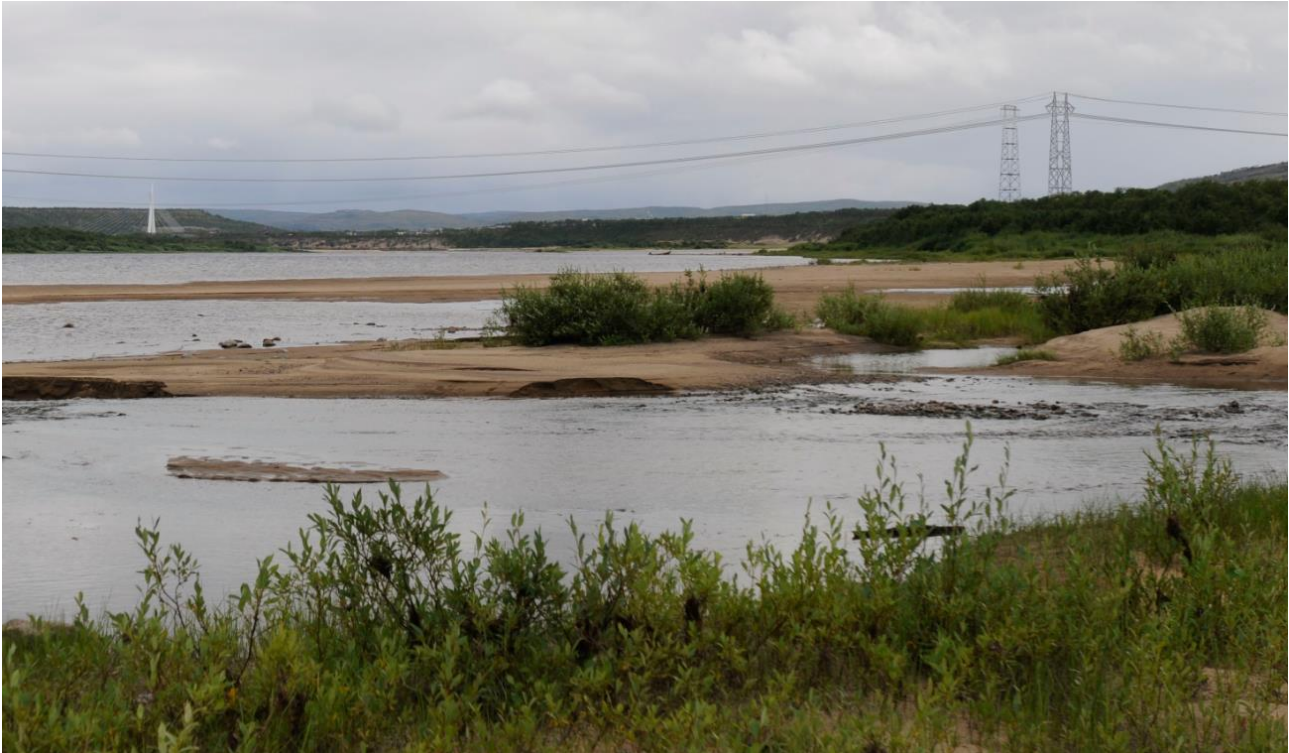
Figur 4-45 Utsnitt 2 av visualisering av nytt spenn (420 kV) over Tanaelva. Det går parallelt med eksisterende 132 kV-ledning.
