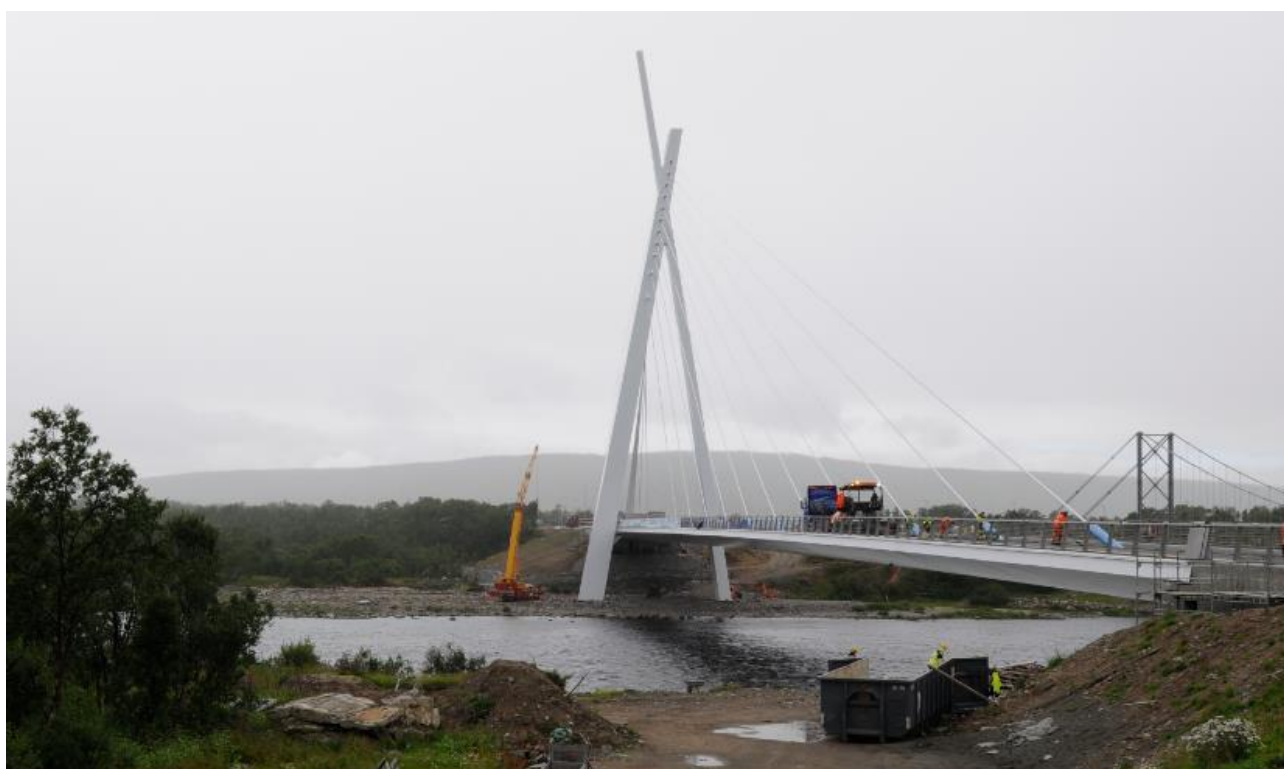
Figur 4-17 Nye Tana bru under bygging sommeren 2020
