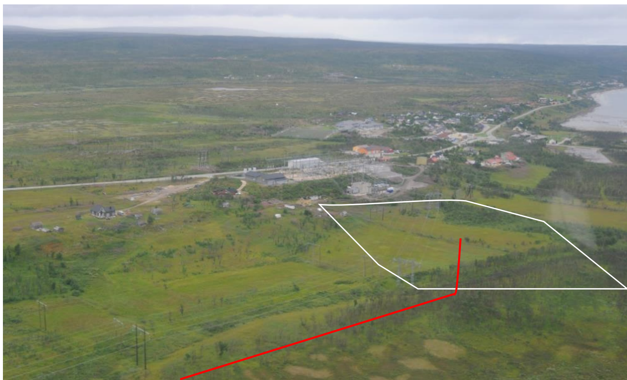
Figur 4-55 Varanger transformatorstasjon i dag. Bildet er tatt fra helikopter. Utvidelse av stasjonstomt er vist med hvit firkant og ny 420 kV ledning med rød strek.
