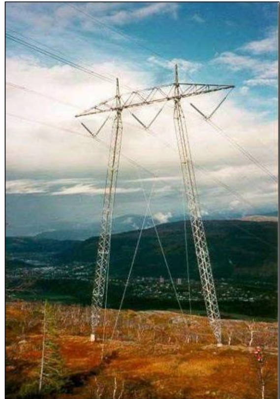
Figur 2-8. Bilder av aktuelle mastetyper, til venstre selvbærende stålmaster (portalmast), høyre: innvendig bardunert mast (M-mast).
