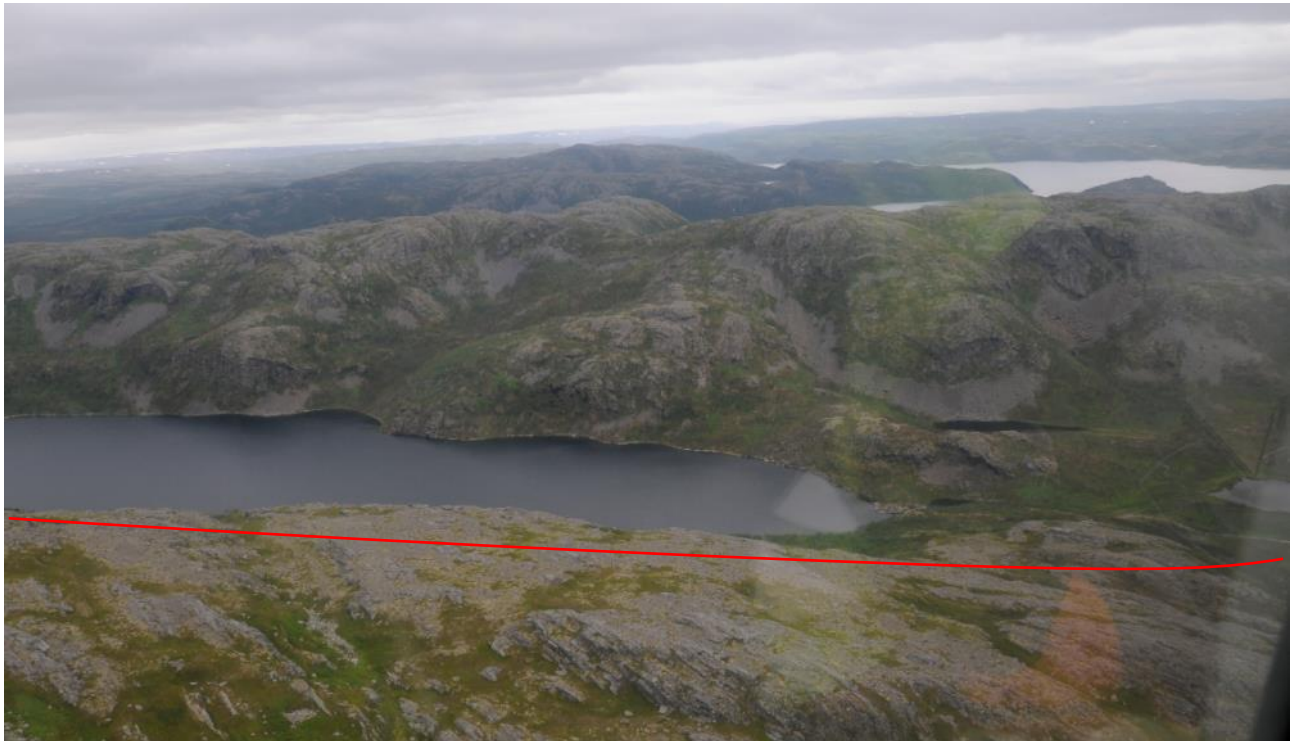
Figur 4-30 Trasé for alternativ 1.4 på østsiden av Helvetesvannet ned mot transformatorstasjon alternativ A. Bildet er tatt fra helikopter ved Jerkum
