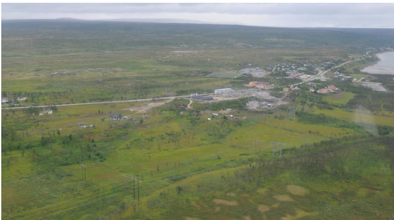
Figur 5-23 Oversiktsbilde av dagens Varangerbotn stasjon og verdiområde K10 til venstre for stasjonen.
