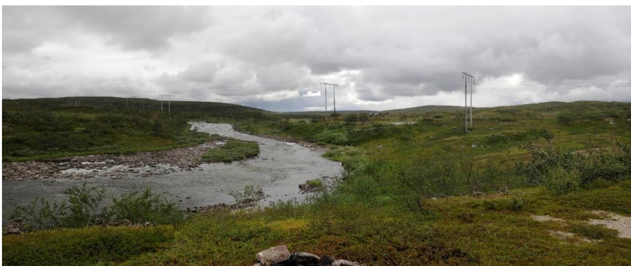
Figur 4-16 Utløpsosen av Sommevannet. Her krysser eksisterende ledninger dalen i randsonen av vannet.
