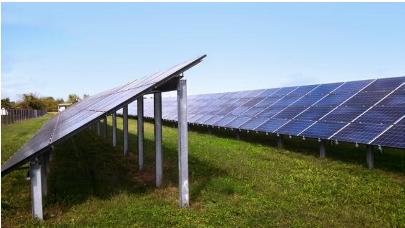
Figur 3: Fast-vinkel installasjonsløsning (foto: Willowbrook Solar)
