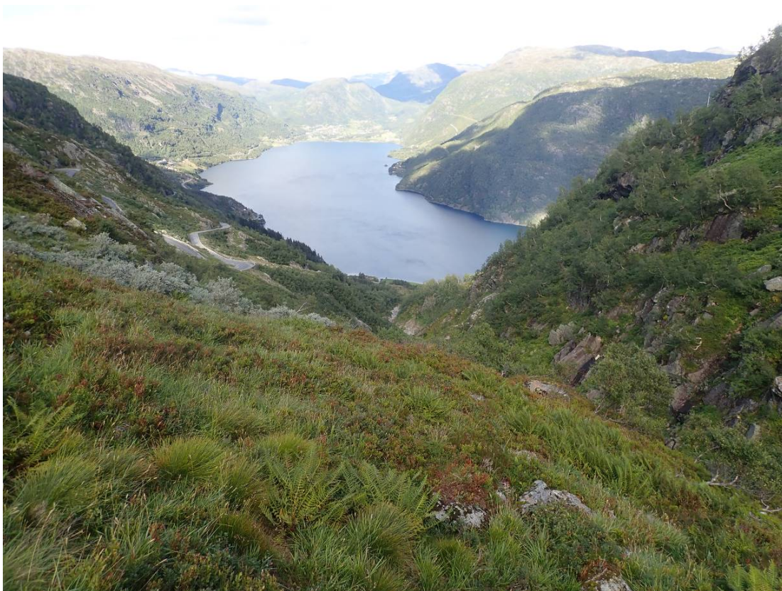
Figur 25 Store deler av rørgaten er gravd ned i veien.
