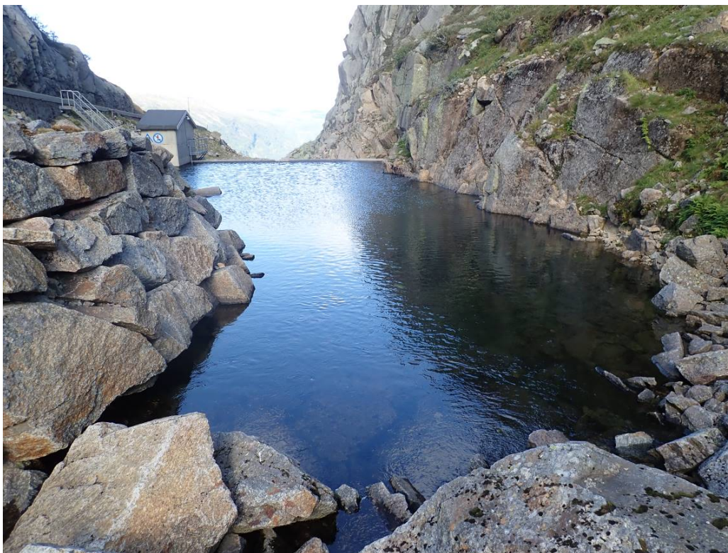
Figur 21 Inntaksdam til Ekkjestølen kraftverk
