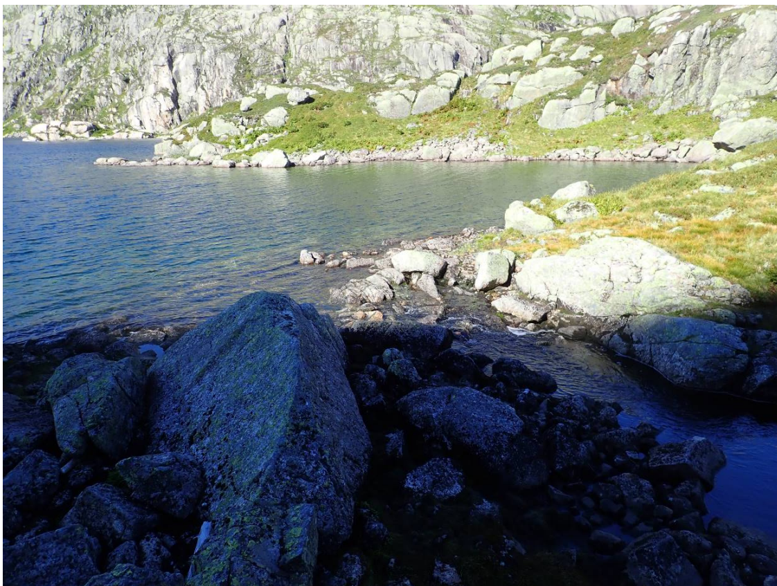
Figur 6 Nærbilde av damsted. Det er synlig berg på nordsiden.
