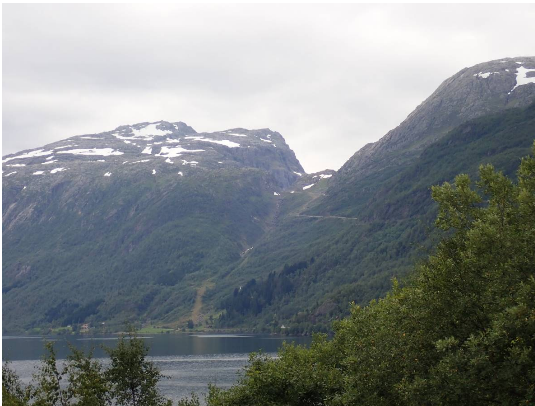
Figur 28 Ekkjeåna og rørgate til Ekkjestølen kraftverk
