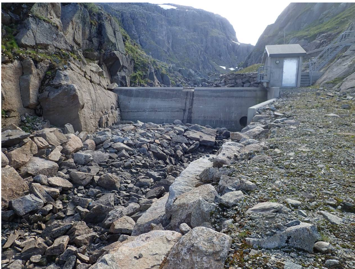
Figur 24 Nedstrøms inntaksdammen til Ekkjestølen kraftverk
