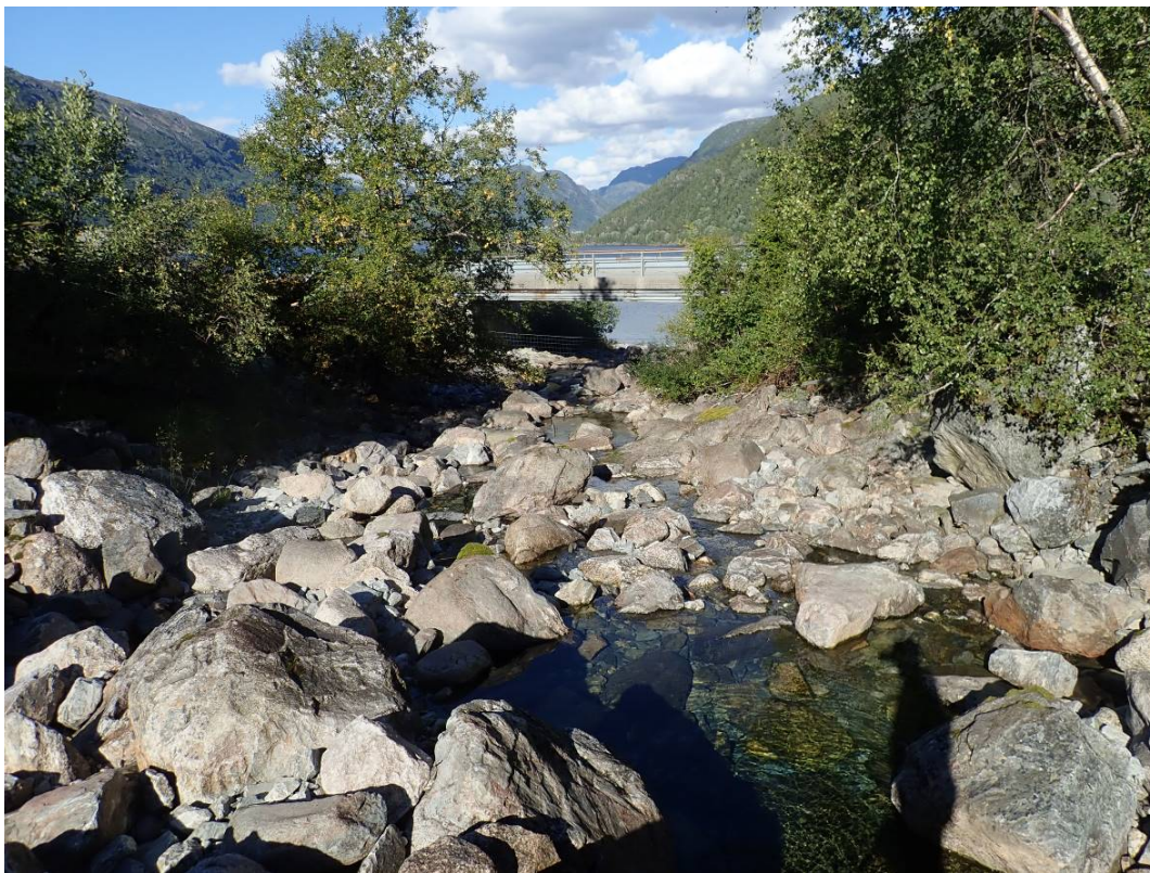
Figur 27 Bru (RV 13) over utløpet til Ekkjeåna like oppstrøms Røldalsvatnet
