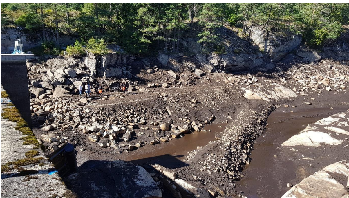
Figur 3: Terreng ved dammen, 2020.
