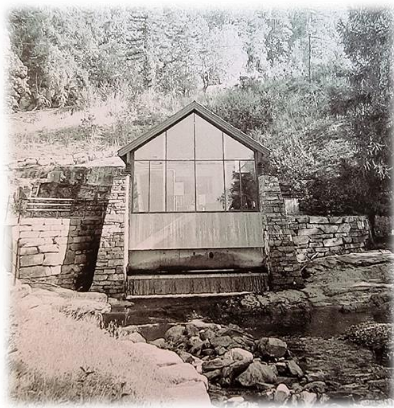
Bilde 13 Eksempel på kraftstasjon innebygget i stein, med en glassvegg
