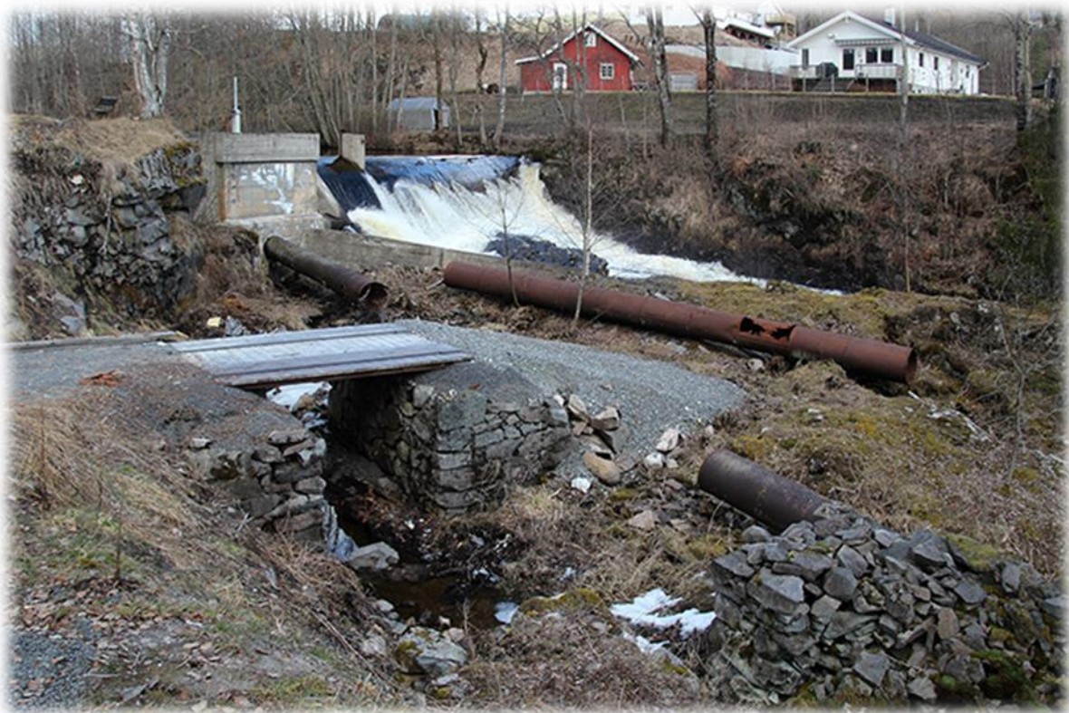
Bilde 1 Eksisterende kraftverks dam og gammel rørgate
