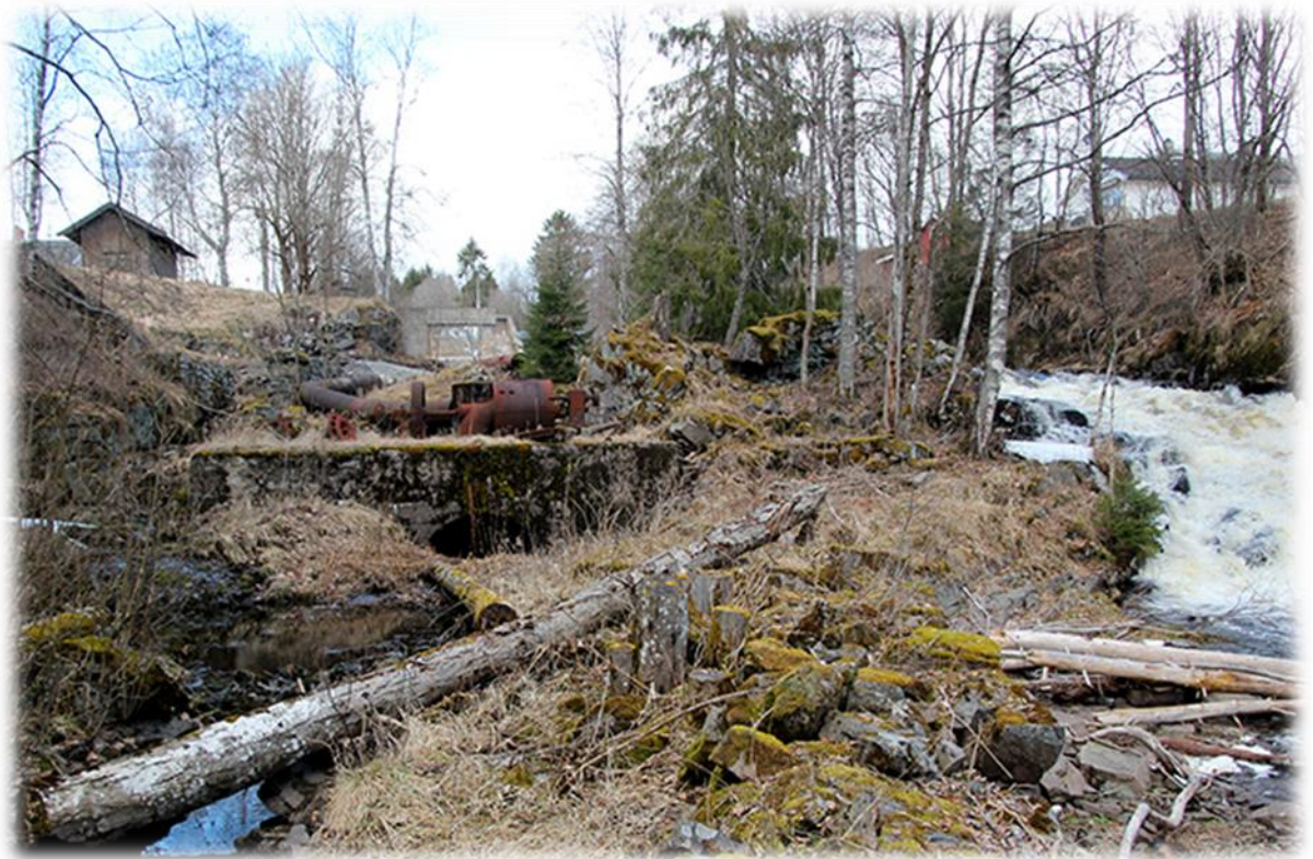
Bilde 2 Kraftstasjons området vises fra nedstrøms gamle konstruksjoner hvor nytt kraftstasjonsbygg planlegges å bygges.
