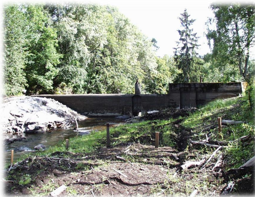
Bilde 21 Bilde fra kraftverksdammen fra 14.8 2000, NVEs befarig
