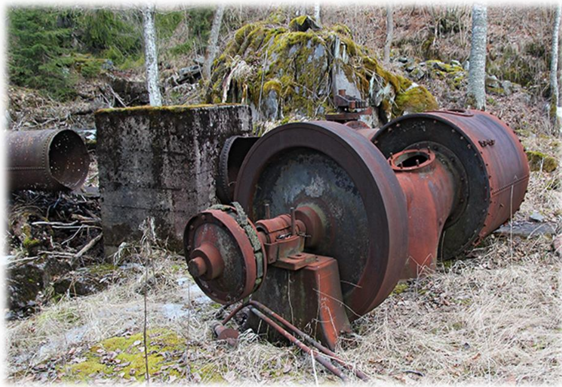
Bilde 12 Fundamentområde for gammel og ny Kraftstasjon
