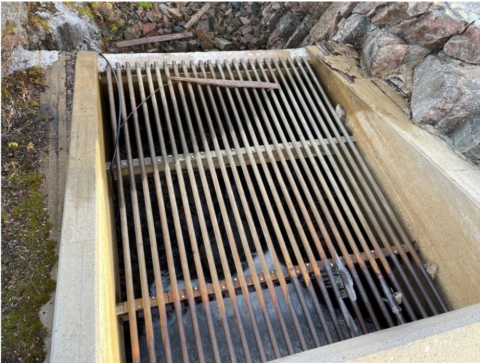
Bilde 5 Inntaksrist sett ovenfra
