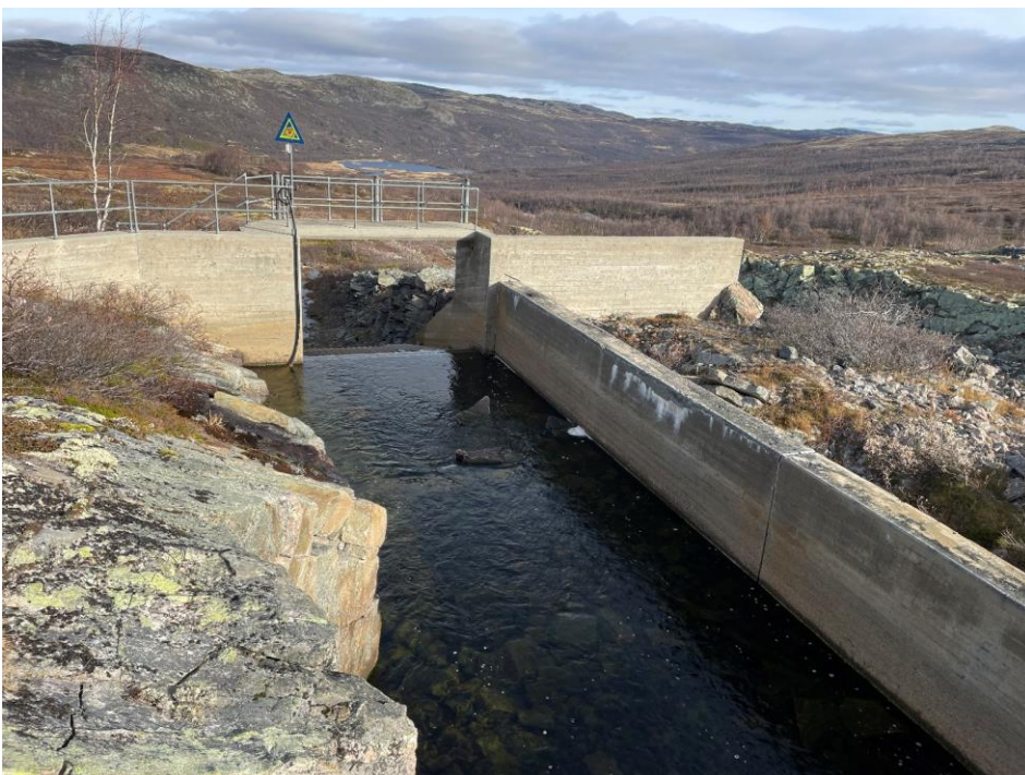
Bilde 2 Bekkeinntaket fra oppstrøms side, med kanal og flomterskel til høyre i bildet
