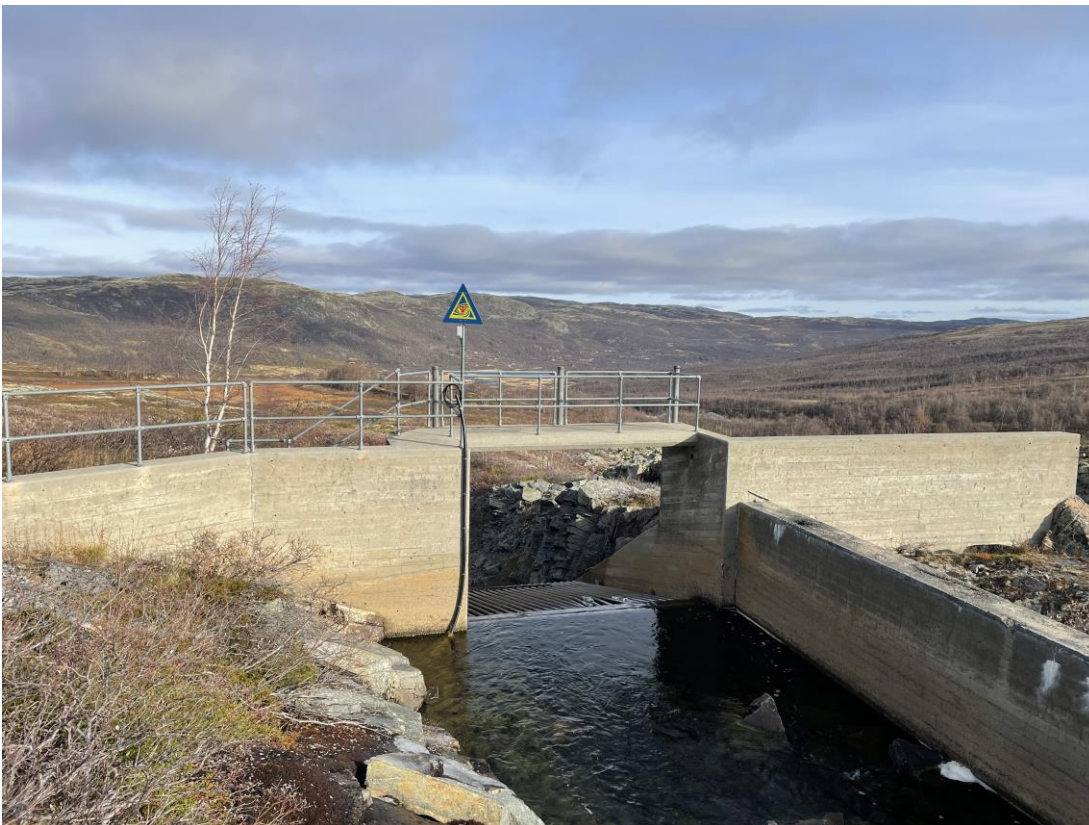
Figur 1 Bekkeinntaket sett fra oppstrøms side
