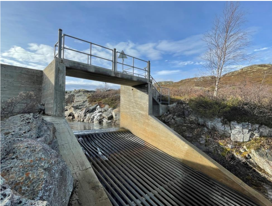
Bilde 7 Bekkeinntaket sett fra nedstrøms side
