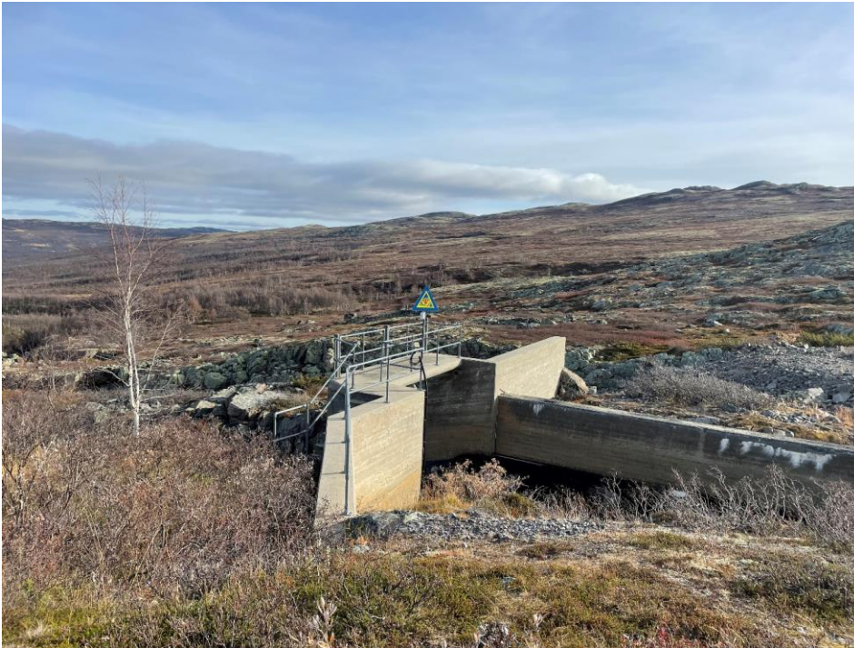
Bilde 1 Bekkeinntaket sett fra oppstrøms, venstre side
