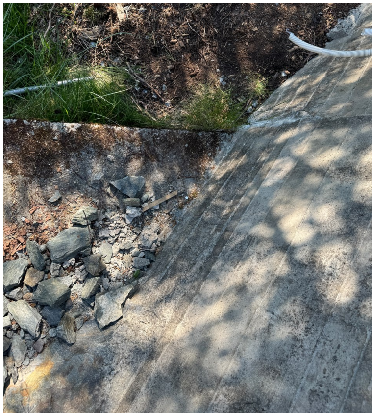
Figur 7-3: Ifm. byggearbeider til bolighus til venstre for dammen er det støpt en mur på dammens venstre vederlag.
