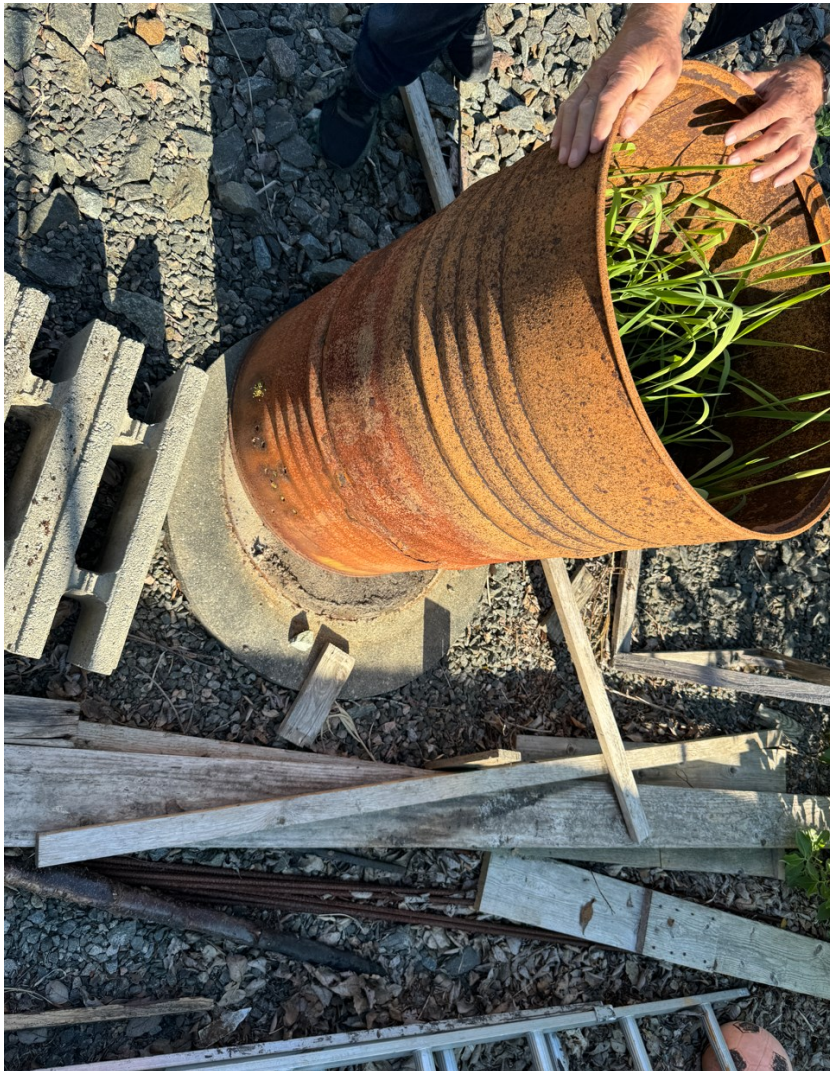
Figur 7-7: Tønne plassert over kum for bunntappeventiler.
