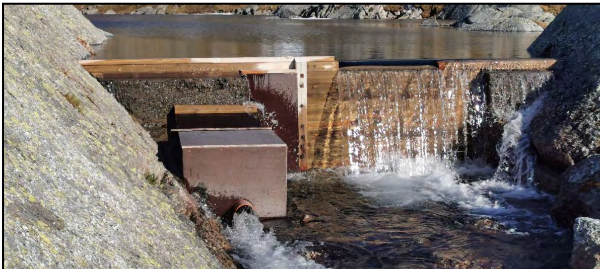
Figur 2-1 Dam Liåvatnet / Foto: Vevelstad kommune
