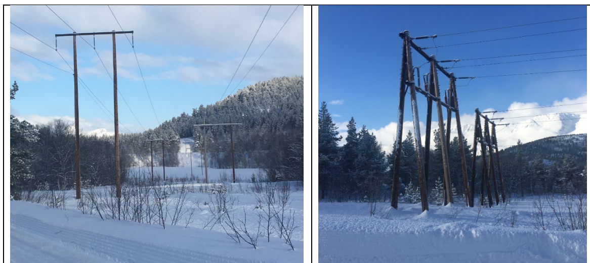
Figur 4: Bilder av mastetyper som planlegges for 66 kV ledningene i Reisdalen. Kabelendemast til høyre planlegges ved innføring til nye Vinnelys stasjon
