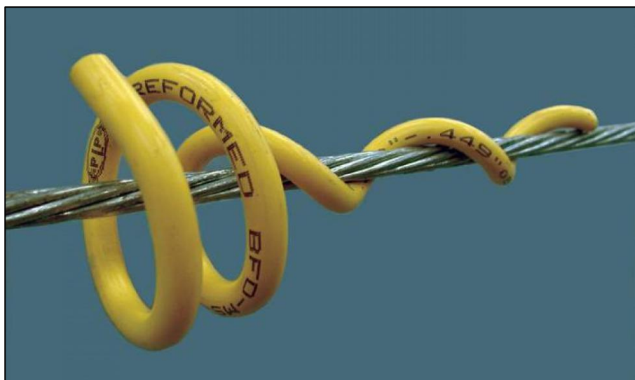
Figur 4-11: Grisehale for synlighetsmerking av kraftledninger.
