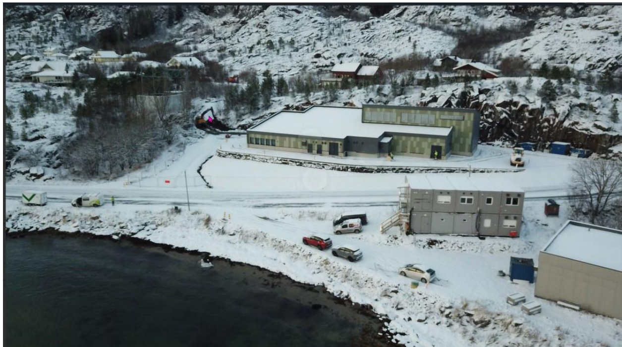
Figur 7: Lødingen transformatorstasjon. Til venstre sees eksisterende muffestasjon som rives.
