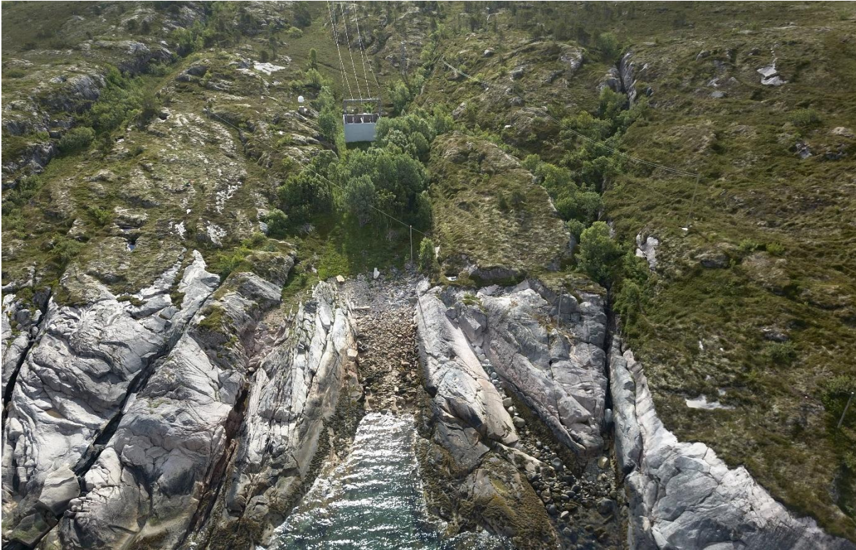
Figur 10 Landtak og muffestasjon/mast på Barøya.
