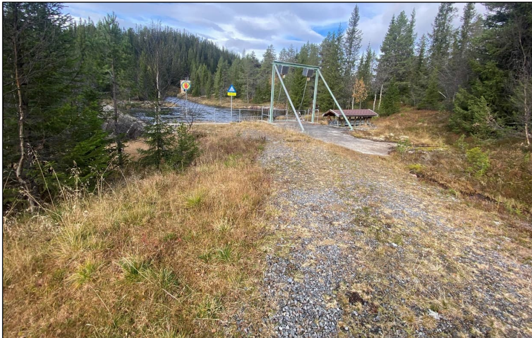
Figur 3-5. Adkomst fra Hundemyrveien til anlegget fra øst. Adkomst til minstevannføringsarrangement vil skje på midlertidig anleggsvei rundt inntak. Riggområde på 40 m 2 vil etableres til venstre i bildet. Foto: Sweco Norge.
