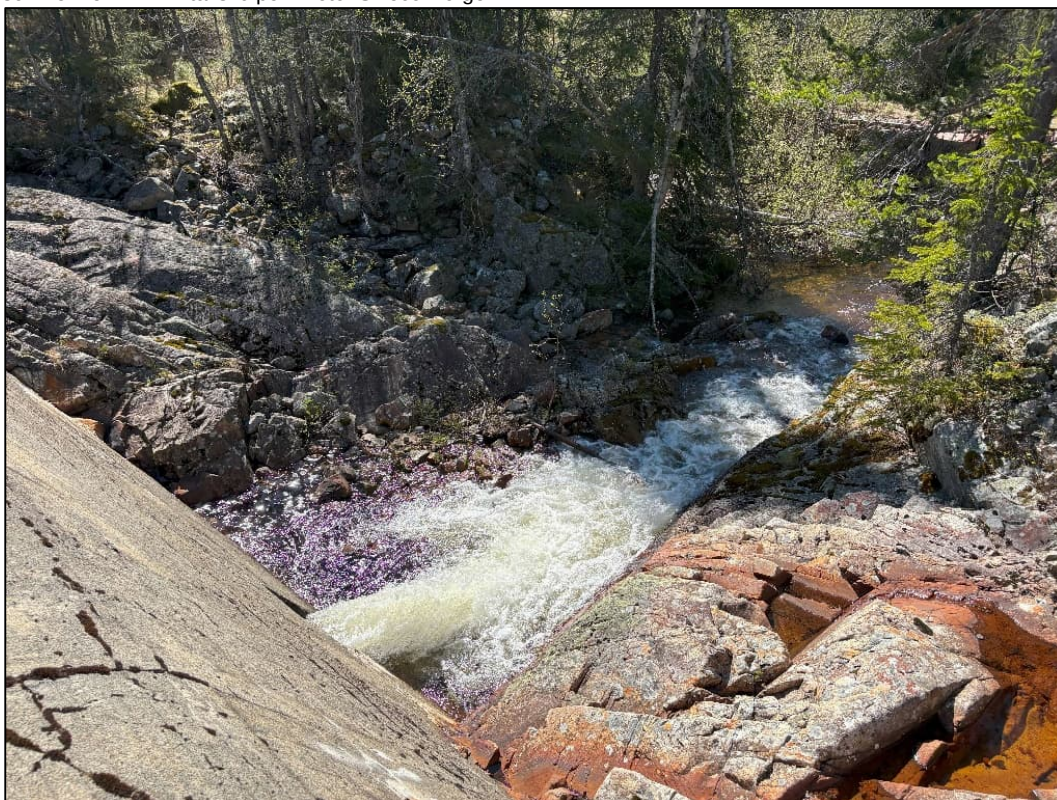
Figur 3-3 Nedstrøms side av eksisterende dam hvor minstevannføringen skal gå, tatt når tappeluken står åpen. Foto: Sweco Norge.
