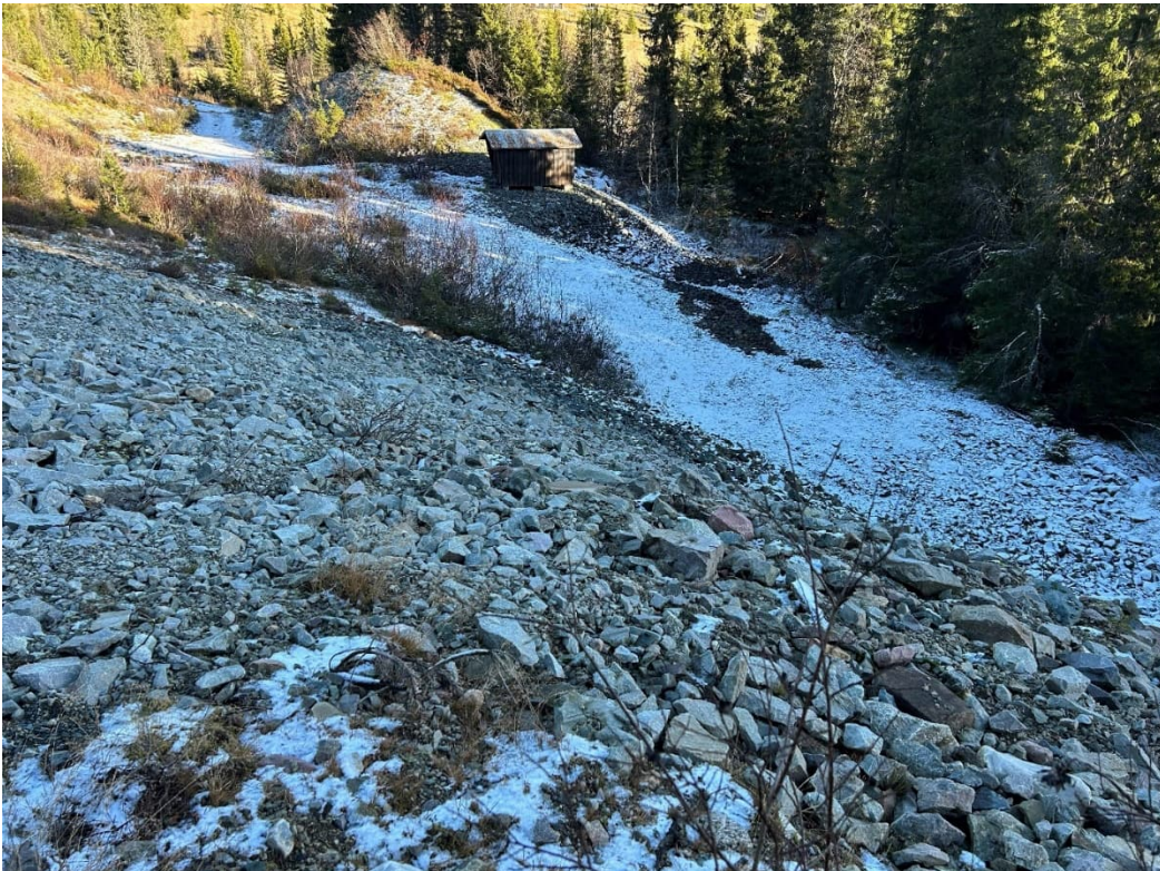
Figur 5-10. Område nord i tiltaksområdet med eksisterende masselager. Adkomstvei til venstre bak i bildet. Foto: Skagerak Kraft.
