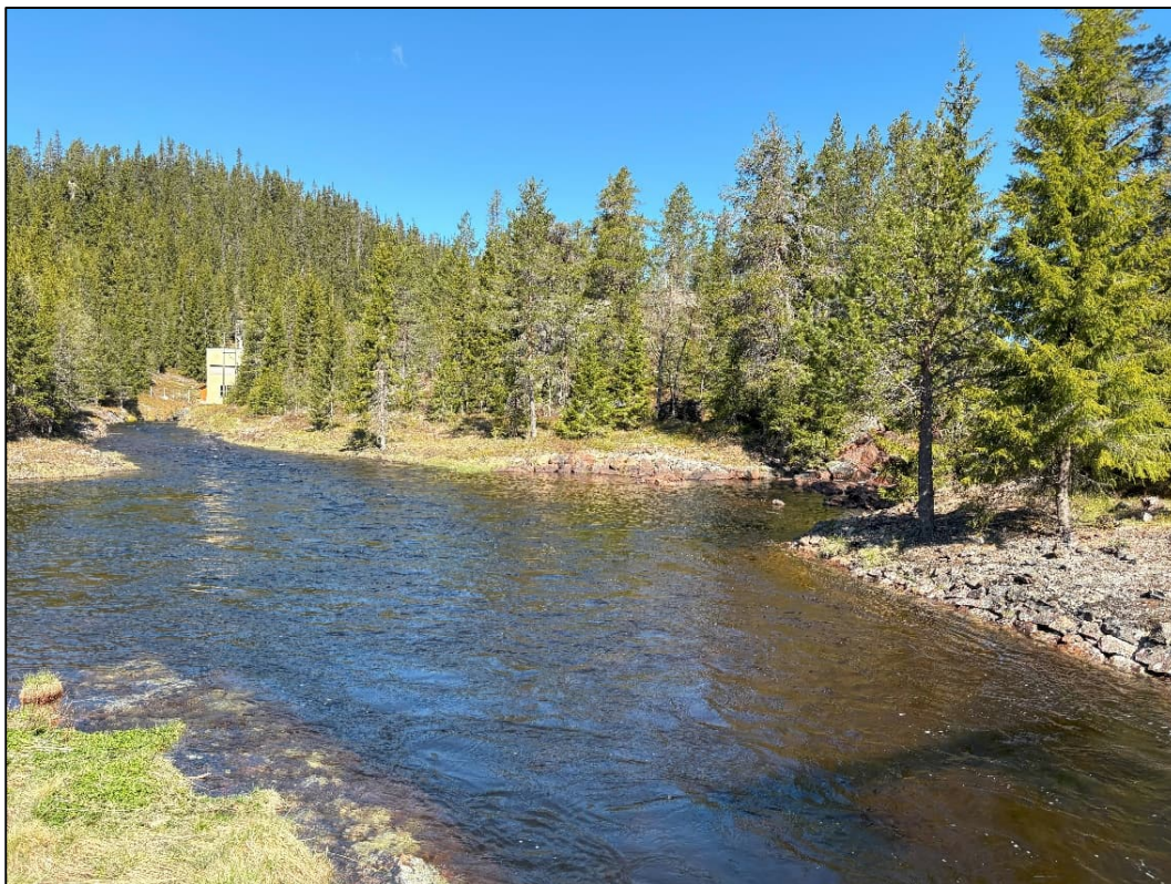
Figur 3-2 Innløpet til bekkeinntaket. Fra høyre ser man tilløpet fra elva Bjordøla. Til venstre ser man avløpet fra Bjordalen kraftverk som renner inn i inntakskulpen. Foto: Sweco Norge.
