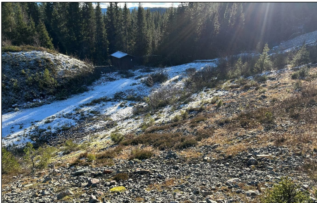
Figur 3-7. Eldre masselager nord for Bjordalen kraftverk som nå vil bli benyttet til uttak av masser til midlertidig anleggsvei og lagring av masser som fjernes fra tiltaksområdet, jfr. Tiltakets arealbruksplan.
