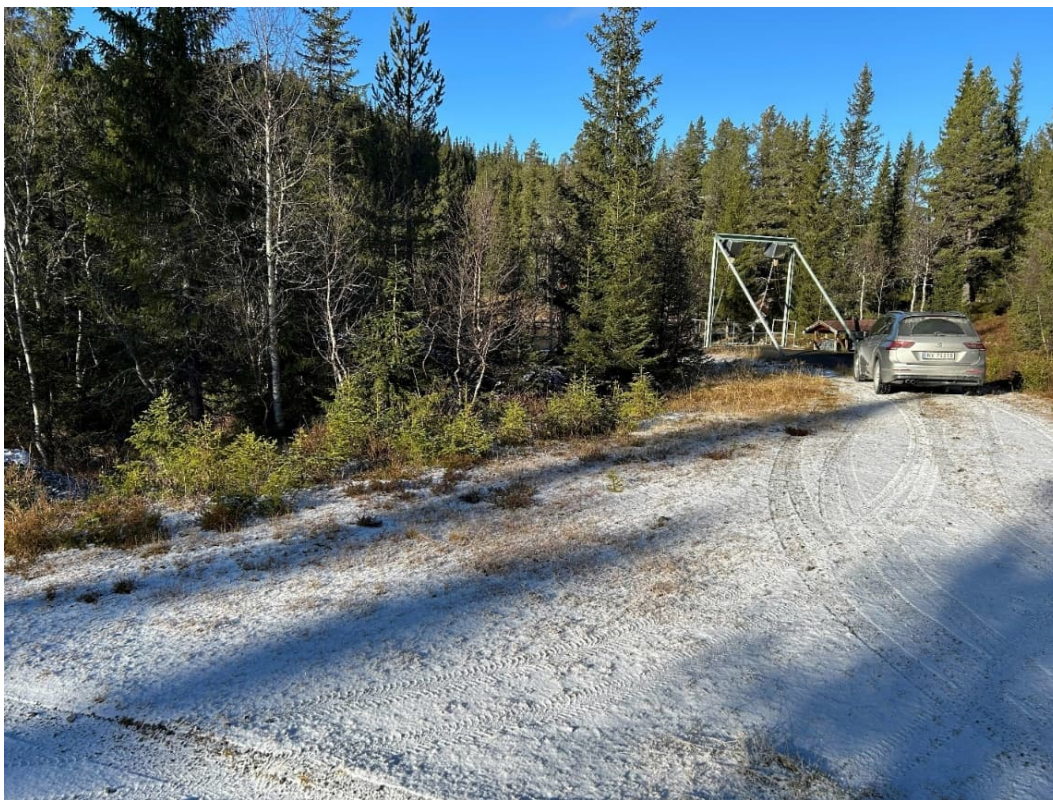
Figur 5-8. Adkomst inn til bekkeinntak. Et mindre riggområde (ca. 40 m 2 ) plasseres i ytterkant av vei til venstre i bildet. Foto: Skagerak Kraft.
