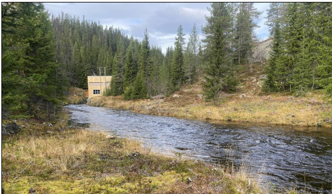
Figur 2-2. Bjordøla oppstrøms dammen med kolleparti nord for dammen til høyre og yngre granskog sør for kanal til venstre. Bjordalen kraftstasjon i bakgrunnen. Foto: Sweco Norge.
