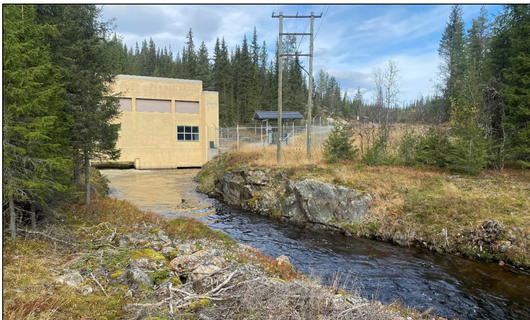
Figur 3-6. Bjordalen kraftverk. Allerede opparbeidet arealer til høyre for bygningene til Bjordalen kraftverk vil benyttes til riggområde. Se også bilder i vedlegg. Foto: Sweco Norge.
