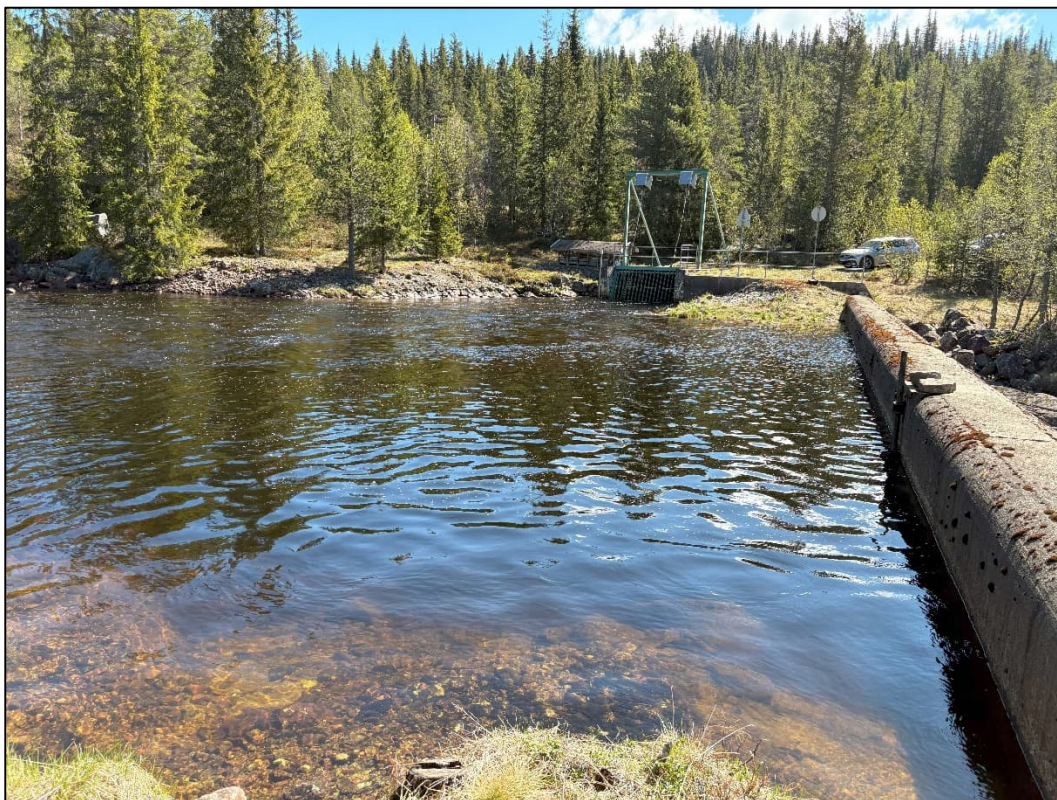
Figur 3-1: Bekkeinntaket Bjordøla sett fra vest. Bakerst i bildet er inntaket som fører vann over til Breivatn. Til høyre i bildet er terskelen som demmer opp inntakskulpen. Foto: Sweco Norge.
