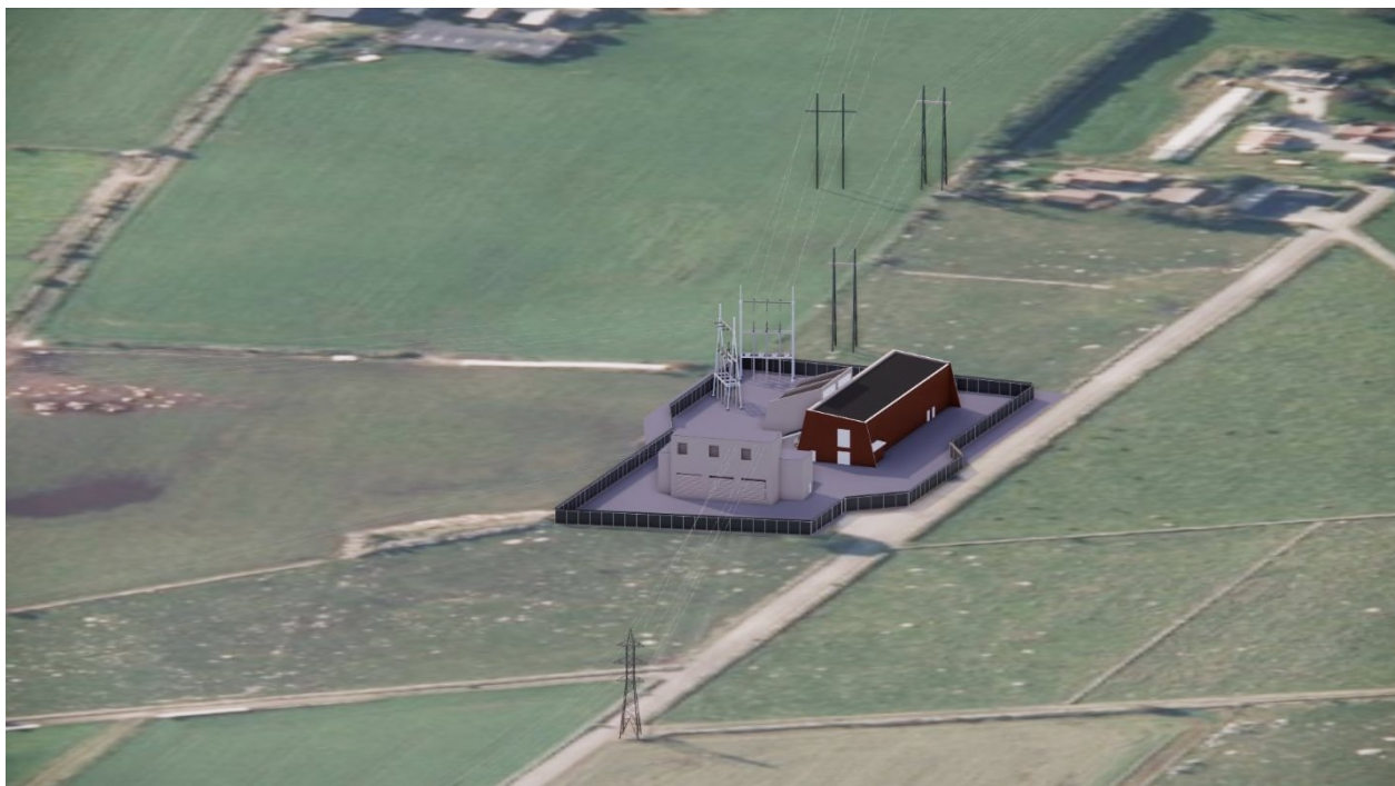
Figur 1 Hatteland transformatorstasjon, sett fra nord
